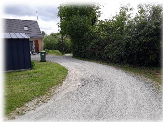
Vue sur l'accès carrossable et la voie de desserte au hameau, en stabilisé - Crédits : DMEAU 2023 (Vue 4)
