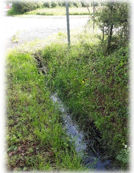
Fossé en eau en bordure Nord du terrain - Crédits : DMEAU 2023 (Vue 2)
