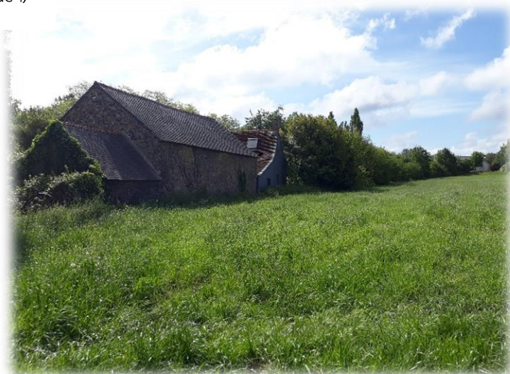
Bâtiment et ancienne grange typique de l'architecture local et d'intérêt patrimonial, contigus au terrain - Crédits : DMEAU 2023 (Vue 4)
