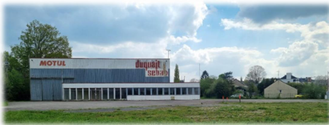
Vue sur les bâtiments Duquait - Crédits : La Boîte de l'Espace
