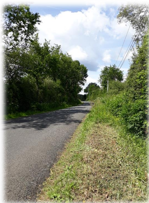
Illustration de la déclivité du terrain naturel et de l'absence de fossé de collecte des eaux pluviales, depuis la rue Jean Vivien, en direction du Nord - Crédits : DMEAU 2023 (Vue 4)
