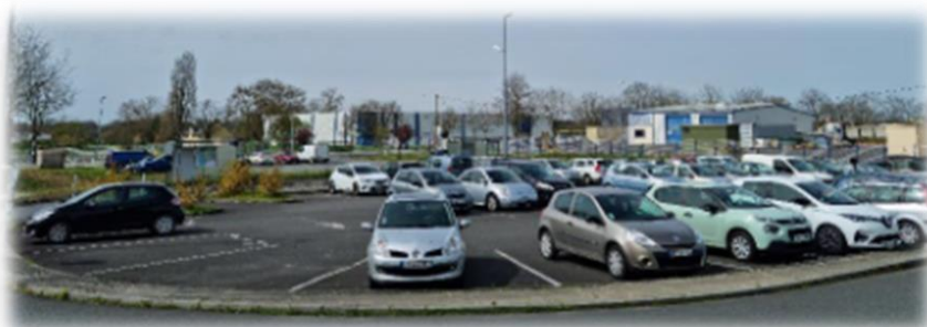
Vue depuis le Sud-Est, sur l'espace de stationnement - Crédits : La Boîte de l'Espace
