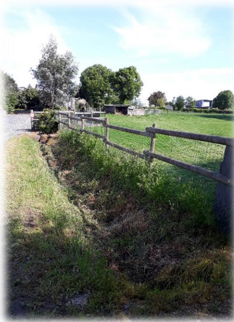
Entrée carrossable au site, également marqué par la présence d'un fossé d'écoulement des eaux pluviales, et vue sur le corps de ferme (situé hors emprise de l'OAP) - Crédits : DMEAU 2023 (Vue 2)
