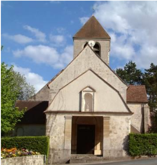
L'église Saint-Martin, rue Gilles-de-Maupéou (chœur et clocher classés monument historique par arrêté du 23 décembre 1931) Source : clocher.org
