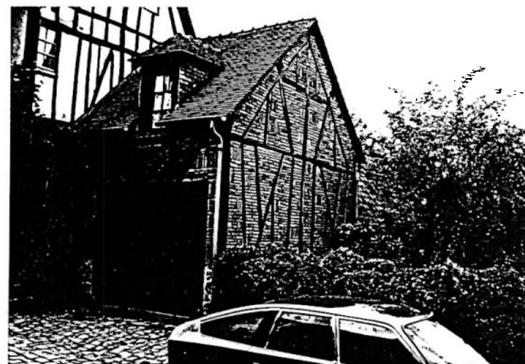
traitement des pignons
