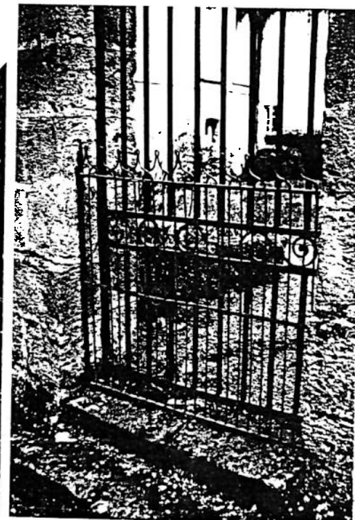
les portails de ferronnerie
