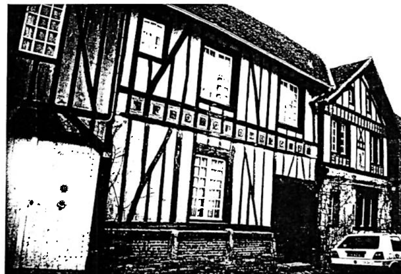
pan de bois remplissage torchis enduit, structure simple
