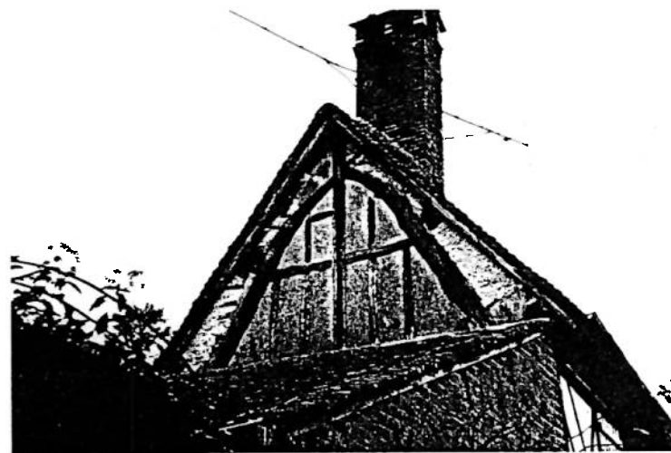
charpente à ferme latine
