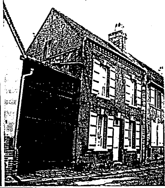
CONSTRUCTION BRIQUES EN TOTALITÉ
