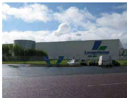
Important volume parallélépipède blanc avec un jeu architectural en façade
