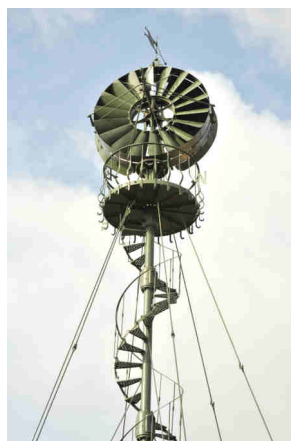
Eolienne de l'usine de l'eau Rue de l'Esterel
