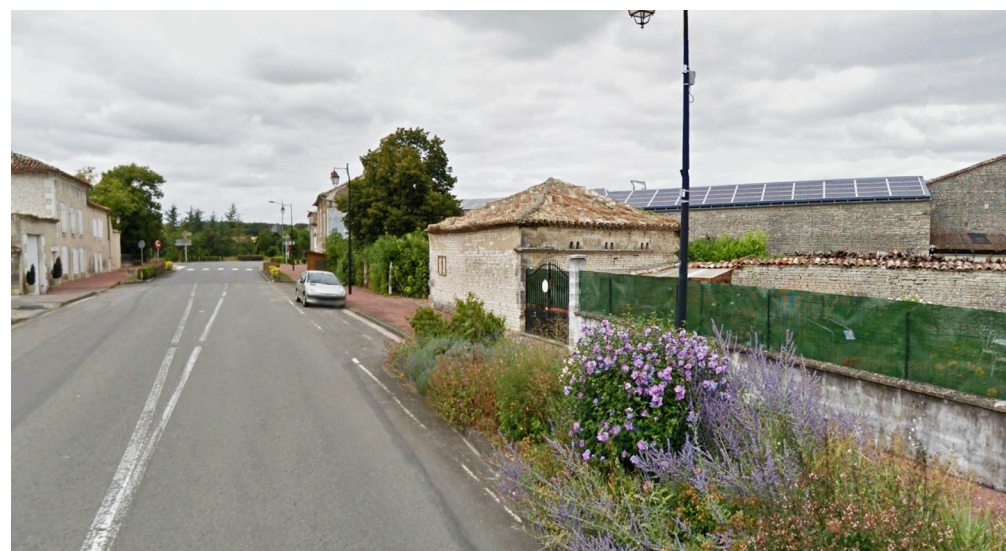
Exemple de bâtiment agricole avec panneaux solaires dans le bourg de Tourriers
