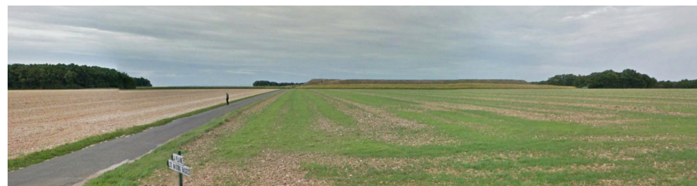
L'impact paysager est ici important : la hauteur de l'ouvrage contraste avec l'horizontalité des champs (Les Gours)
