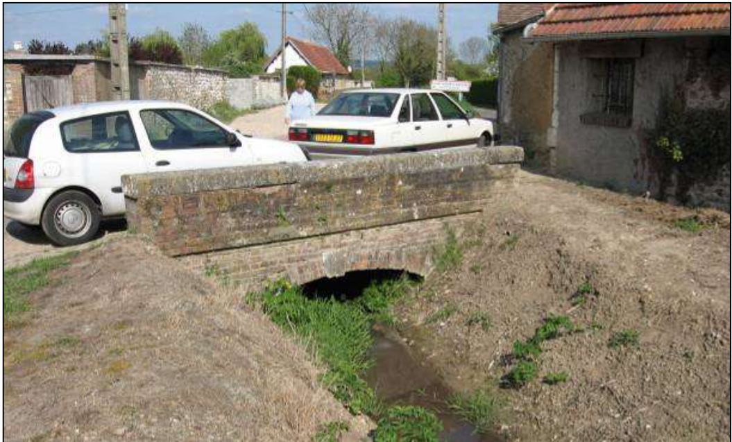
Figure 1 : Pont arche du VC15
