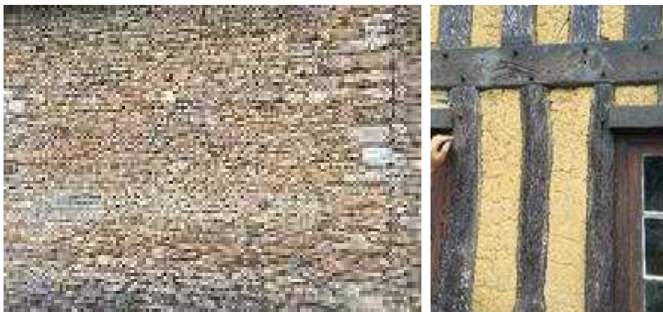
Mur en moellons – Paint-Pierre de Bailleul / Pan de bois (source : CAPLA Architecture)
