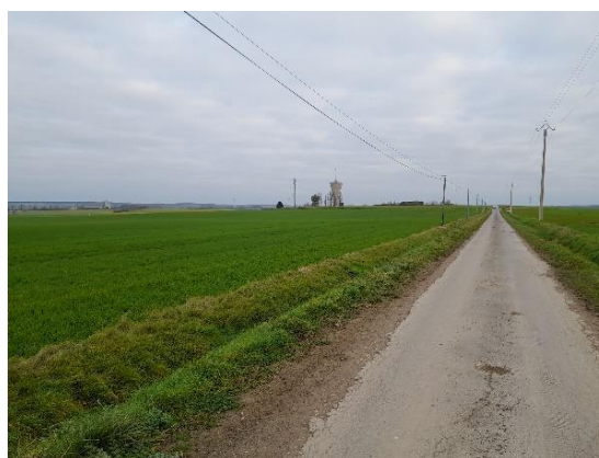
Voie intercommunale. Nord du hameau. Vue en direction de la D960
