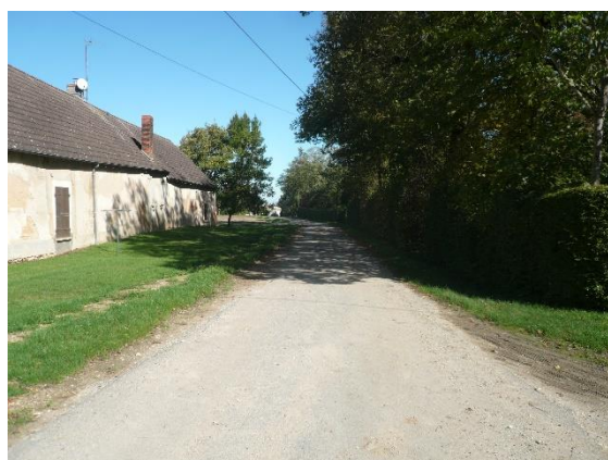
Voie intercommunale à l'intérieur du hameau, près de l'accès au château
