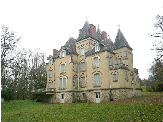
Façade arrière du château
