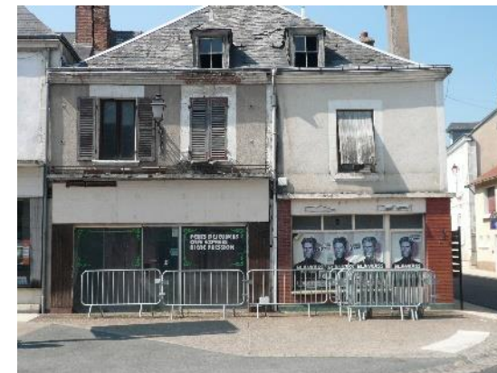
3. Vatan. Commerce en RDC et logement en étage, en centre bourg dense. Recommandation : opération de réhabilitation ou de démolition-reconstruction avec conservation des volumes bâtis sur 2 niveaux + combles. A envisager : conservation de commerces en RDC.
