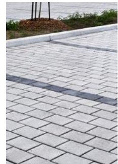
Les pavés drainants
