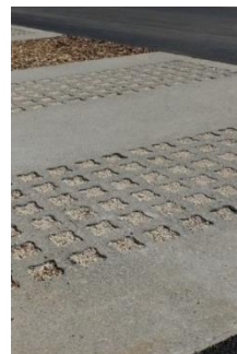
Béton alvéolaire avec un remplissage gravillonné
