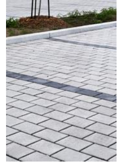
Les pavés drainants
