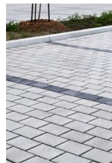
Les pavés drainants
