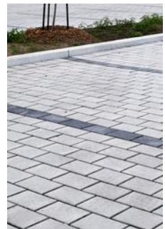
Les pavés drainants
