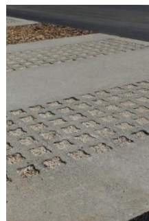
Béton alvéolaire avec un remplissage gravillonné
