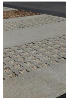
Béton alvéolaire avec un remplissage gravillonné
