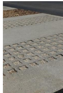
Béton alvéolaire avec un remplissage gravillonné
