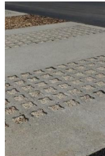
Béton alvéolaire avec un remplissage gravillonné
