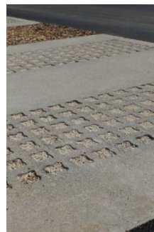
Béton alvéolaire avec un remplissage gravillonné
