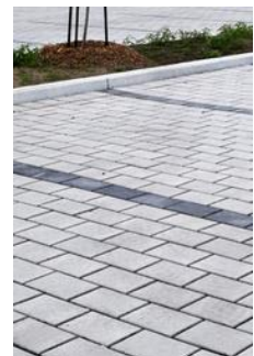
Les pavés drainants
