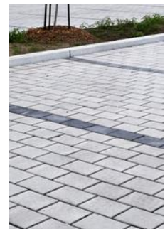
Les pavés drainants
