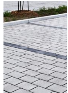
Les pavés drainants
