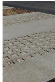
Béton alvéolaire avec un remplissage gravillonné
