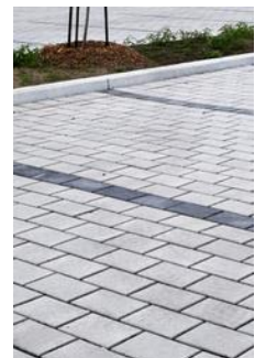
Les pavés drainants
