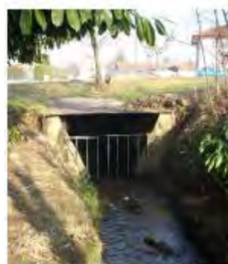
Nord de la zone d'étude (Aval)
