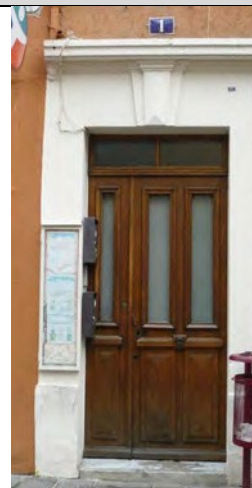
N°1 DEGAGER LES JAMBAGES
