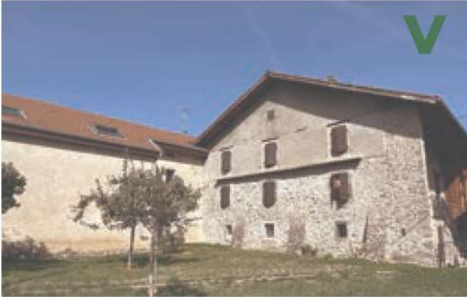
Loyer d'en bas. Exemple de bâti avec percements axés, volets bois et des barreaux au rez-de-chaussée pour sécuriser.
