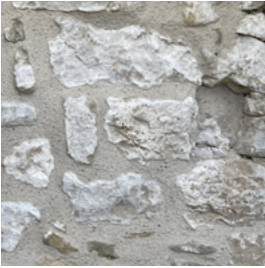
Restauration du mur d'enceinte du château de Clermont-en-Genevois
