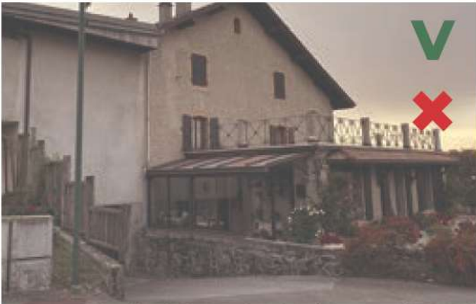
Brens. Extension à toit plat et véranda a l'avantage de pouvoir être lue comme un appendice. Quid sur sa composition.
