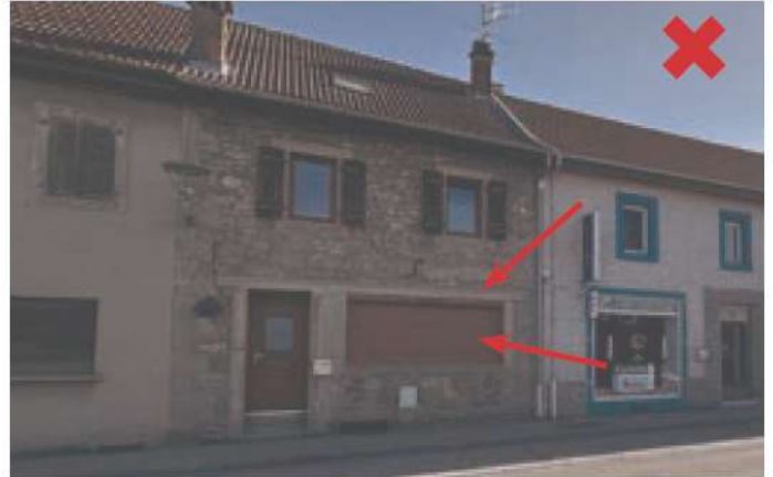
Bons. Agrandissement de la baie du RDC hors échelle avec volet roulant. Présence de l'arc de décharge de la baie d'origine.
