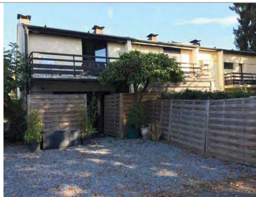
Panneaux occultants : interdit
