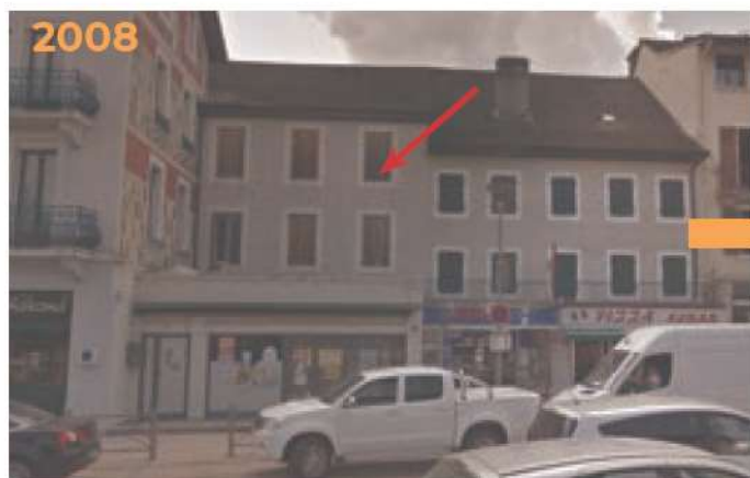
Bons-en-Chablais. Av du Léman. Les volets battants ont disparus à profit de volets roulantes. Ceci a appauvri la façade. Deux nouveaux velux sont apparus en toiture et ils sont alignés aux percements de la façade.
