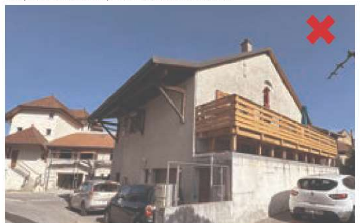
Bons-en-Chablais. Création d'un balcon avec une structure bois complètement incohérent.
