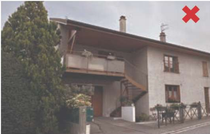
Brens. Mise en place d'un escalier métallique avec terrasse.
