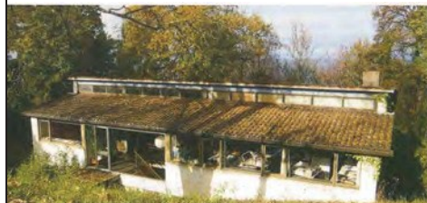
69 boulevard de la Corniche
