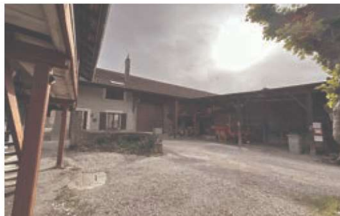
Ferme double avec cour sur rue, Langin.
