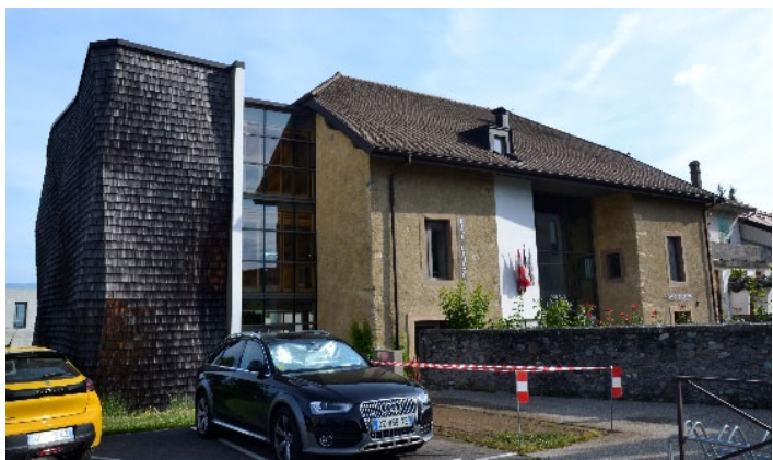
Exemple de la réhabilitation et extension contemporaine qualitatives
