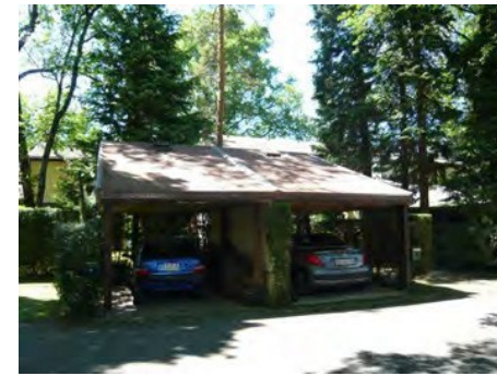
Abri sans local de rangement avec mur maçonné
