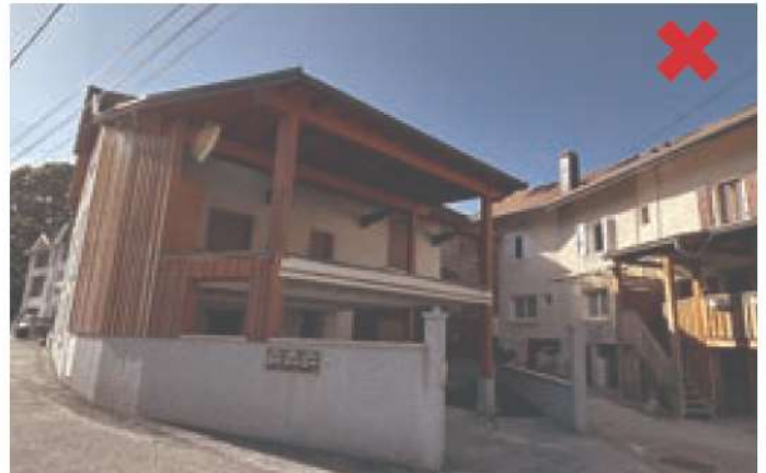
Bons-en-Chablais. Extension en bois pour abriter les voitures qui est trop massive et incohérente avec l'architecture
