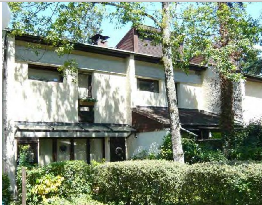
Auvent vitré au-dessus d'une baie
