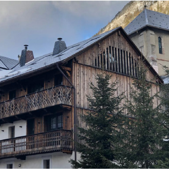
Réhabilitation d'une ferme Abondance
