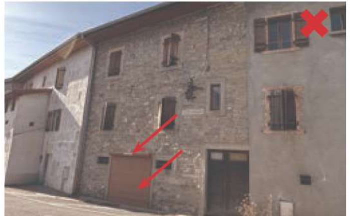
Bons. Agrandissement de la baie du RDC pour créer un garage avec volet roulant extérieur.
