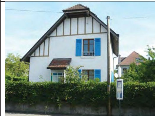
Muret maçonné doublé d'une haie
