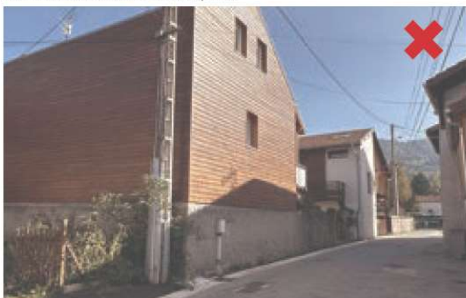
Bons-en-Chablais. L'enduit a été substitué par du bardage bois.
