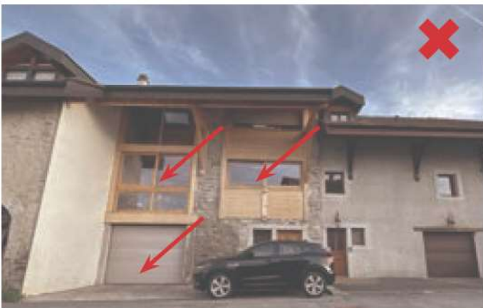
Graizier. Percements trop importants qui ne respectent pas les proportions historiques.
