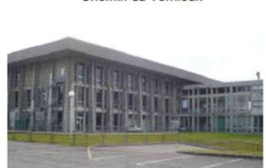
Maison des Sports – façade béton brut
