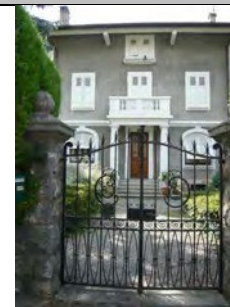
N°32 – 1928 Protection contrôlée
