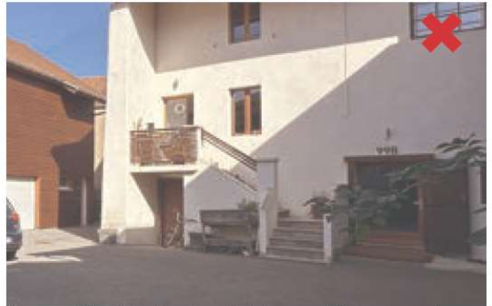
Bons-en-Chablais. Escalier d'origine modifiée avec mise en œuvre d'un garde-corps et création de pilastre de balustrade.
