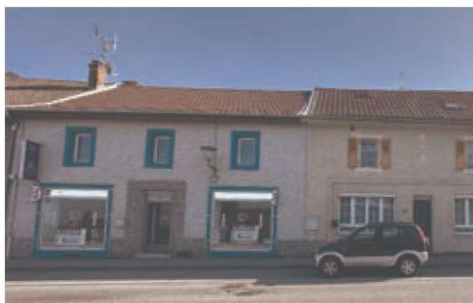
Maison traversante avec commerce, Bons-en-Chablais centre
