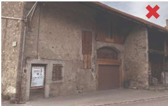
Brens. Insertion d'une porte de garage basculante et changement de la taille de l'ouverture d'origine
