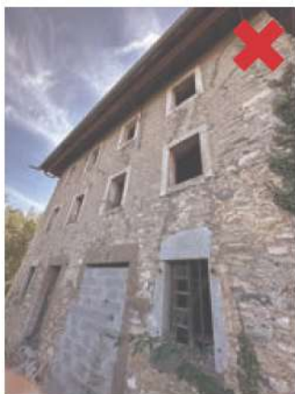
Bons-en-Chablais. Ancien moulin en ruine. L'appareillage est bien visible et l'enduit a disparu.
