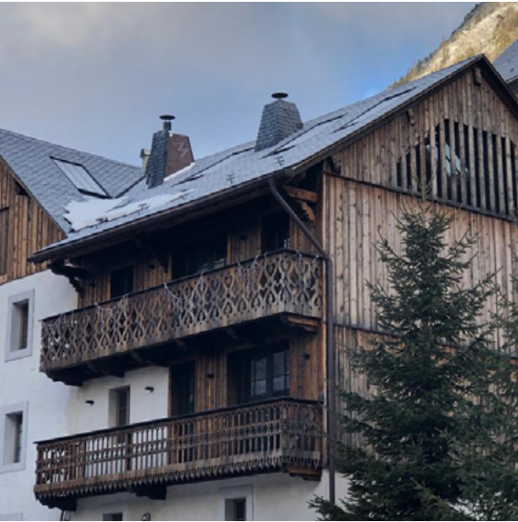
Réhabilitation d'une ferme Abondance
