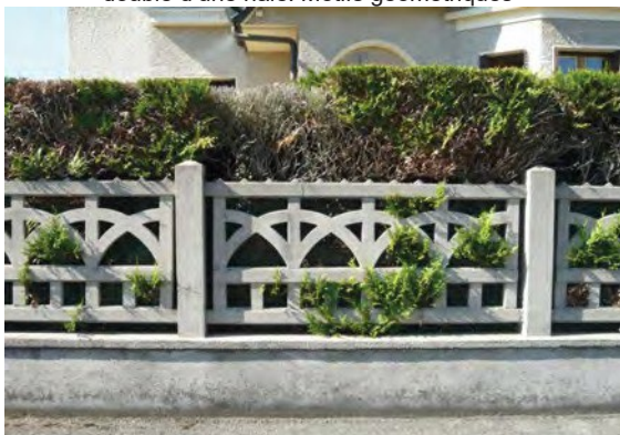
Mur en pierres et éléments préfabriqués en béton
