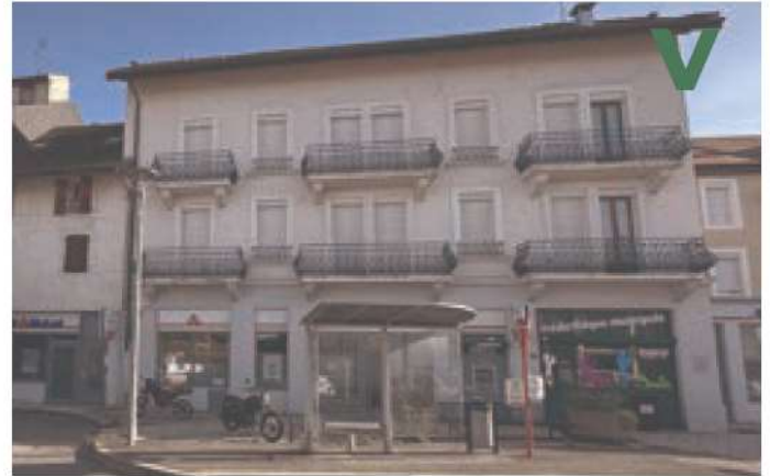
Bons-en-Chablais. Balcon avec garde-corps en ferronnerie.
