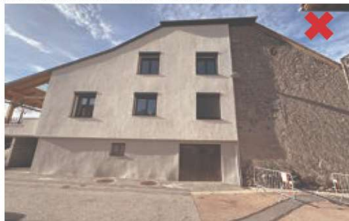
Bons-en-chablais. Exemple de réhabilitation énergétique qui a créé un effet champignon entre le bassement non isolé et les étages. De plus, l'écriture architecturale des menuiseries et des BSO a complètement changé le patrimoine
