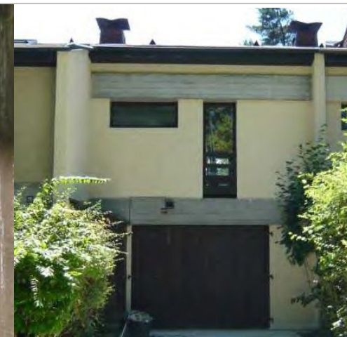
Linteau béton brut non peint
