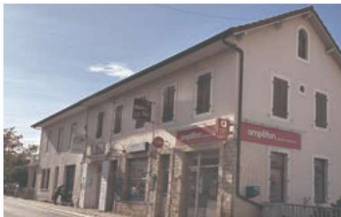
Maison traversante avec commerce, Bons-en-Chablais centre
