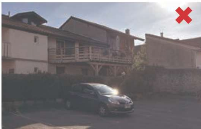
Bons-en-Chablais. Création d'un balcon très grand avec une structure bois.
