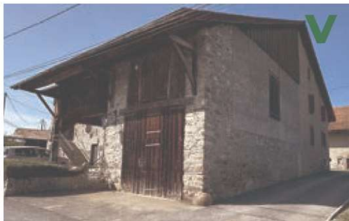
Loyer d'en bas. Conservation de la porte de grange en bois qui est partie intégrante d'un élément complet en bois
