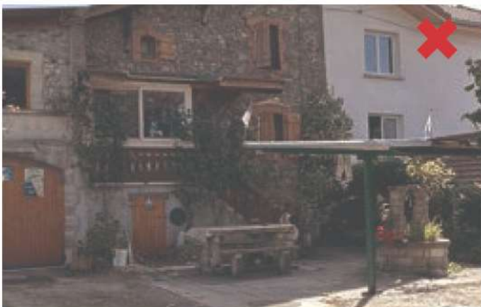
Loyer d'en bas. Création d'une véranda d'entrée en haut de l'escalier et mise en place d'un garde-corps en bois
