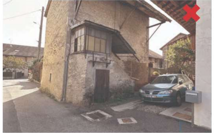
Loyer d'en haut. Création d'une structure pour protéger l'entrée
