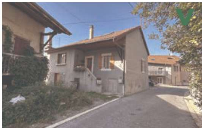
Bons-en-Chablais. Escalier maçonnée avec garde-corps maçonné.
