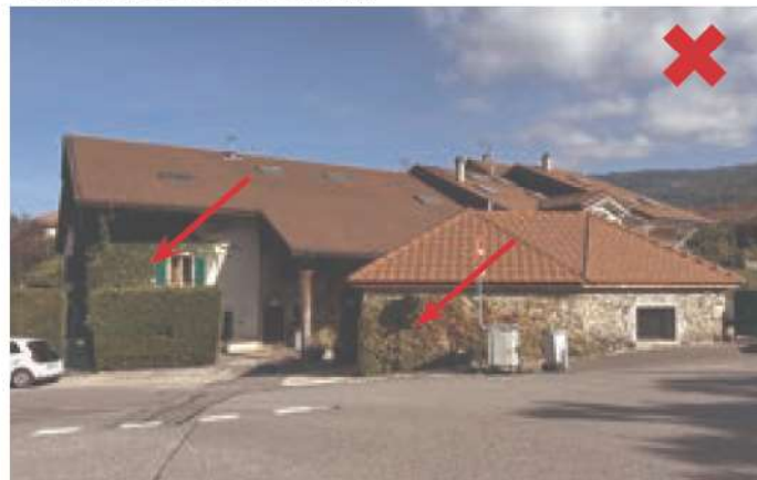
Bons-en-Chablais. D'une manière générale, il est préférable d'éviter la végétation grimpante en façade.
