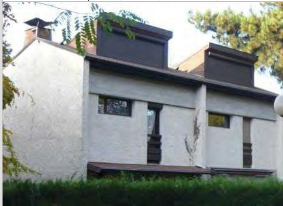
Linteaux en béton brut apparent
