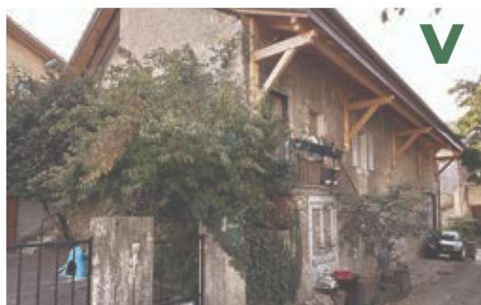
Bons-en-Chablais centre. Passé de toit avec potence. Chevrans et pannes visibles.
