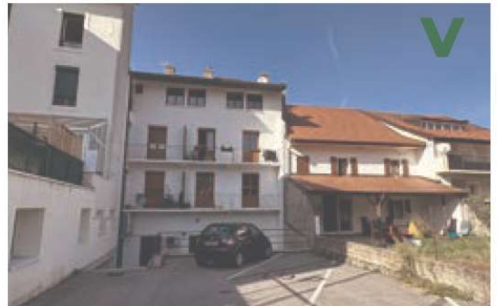
Bons-en-Chablais. Balcon en arrière d'un immeuble avec garde-corps en ferronnerie.
