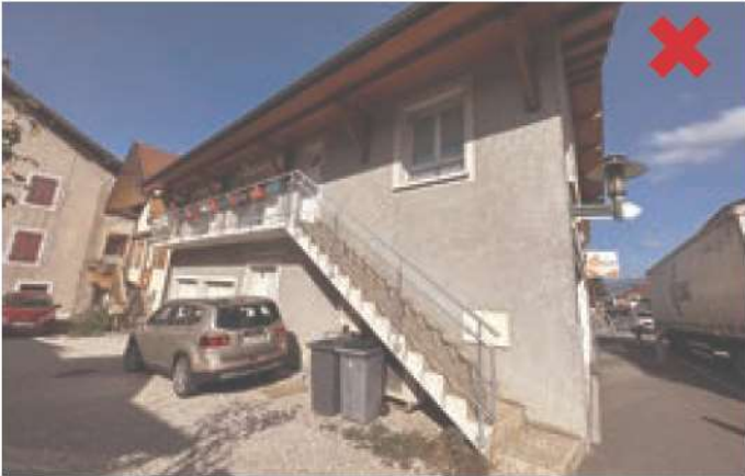
Bons-en-Chablais. Escalier moderne avec garde-corps préfabriqué en verre
