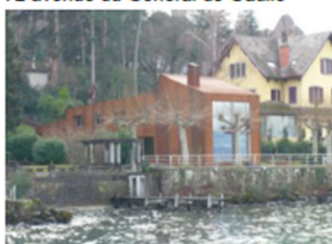
Casa 26 - façade acier corten
