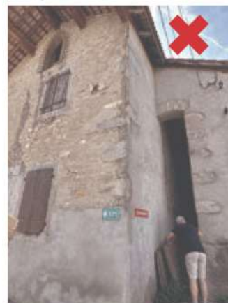
Bons-en-Chablais. Ancien moulin : présence d'enduit ciment et absence d'enduit. Fissures à consolider.
