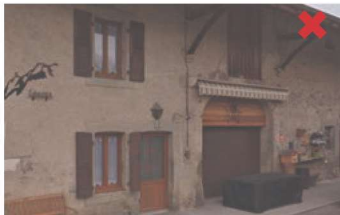
Les Granges. Mise en place de volet roulant extérieur.
