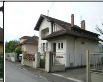
N°5 – 1931 Protection contrôlée
