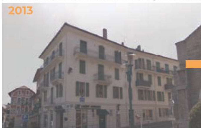
Bons-en-Chablais. Av du Léman. Changement au niveau des protections solaires : les volets battants ont disparus à profit de volets roulantes. Ceci a appauvri la façade.
