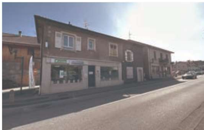
Maison traversante avec commerce, Bons-en-Chablais centre.
