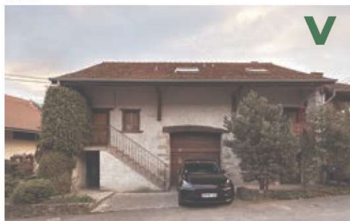
Les Granges. Exemple de porte de grange avec imposte indépendante en bois et porte d'accès au centre
