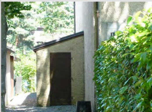
Appentis sur pignon
