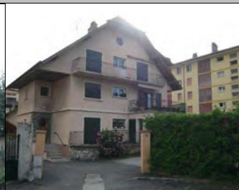
N°6 – 1954 Protection contrôlée
