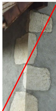
Enduit en surépaisseur d'une chaîne d'angle en pierres
