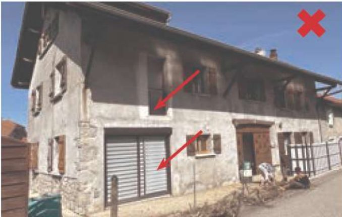
Loyer d'en bas. Dépose de l'allègé pour créer une porte fenêtre au R+1 et agrandissement de la baie du RDC avec volet roulant.
