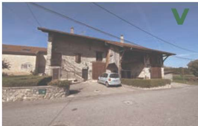
Loyer d'en bas. Escalier en maçonnerie et garde-corps en métal.
