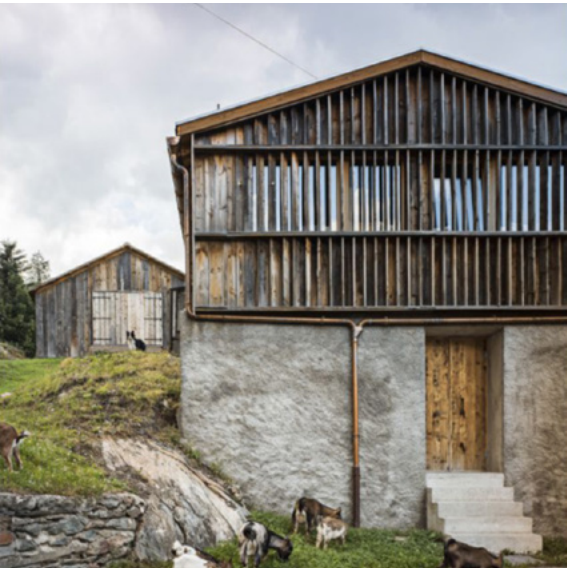
Réhabilitation d'une grange Finhaut (Suisse)
