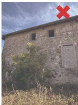
Bons-en-Chablais. Ancien moulin en ruine. L'appareillage est bien visible et l'enduit a disparu.
