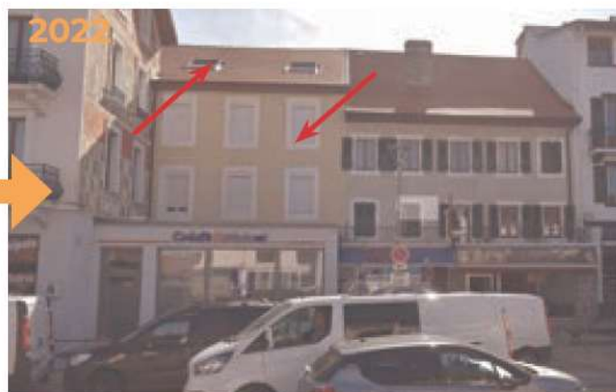
Bons-en-Chablais. Av du Léman. Les volets battants ont disparus à profit de volets roulantes. Ceci a appauvri la façade. Deux nouveaux velux sont apparus en toiture et ils sont alignés aux percements de la façade.
