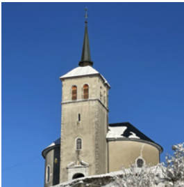
Restauration de la partie supérieure du clocher de l'Eglise Sainte-Madeleine à Saxel
