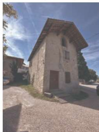
Bons-en-Chablais. Ancien moulin : présence d'enduit ciment et absence d'enduit. Fissures à consolider.
