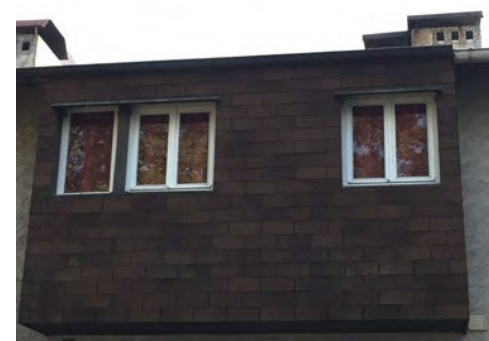
Menuiseries remplacées par un modèle à 2 vantaux
