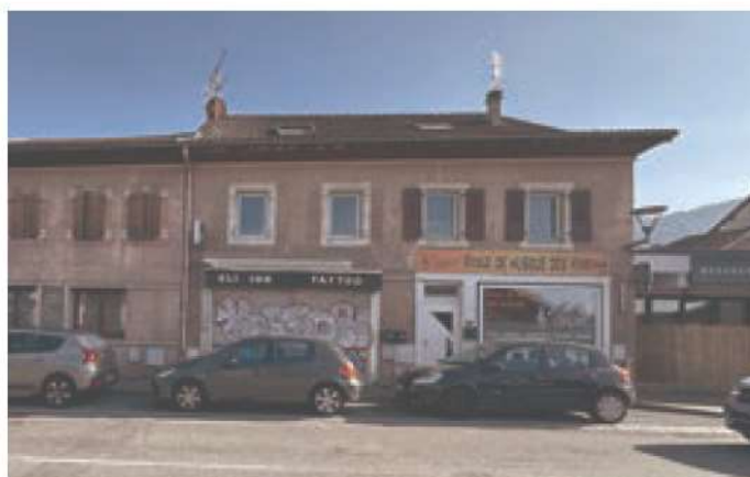
Maison traversante avec commerce, Bons-en-Chablais centre
