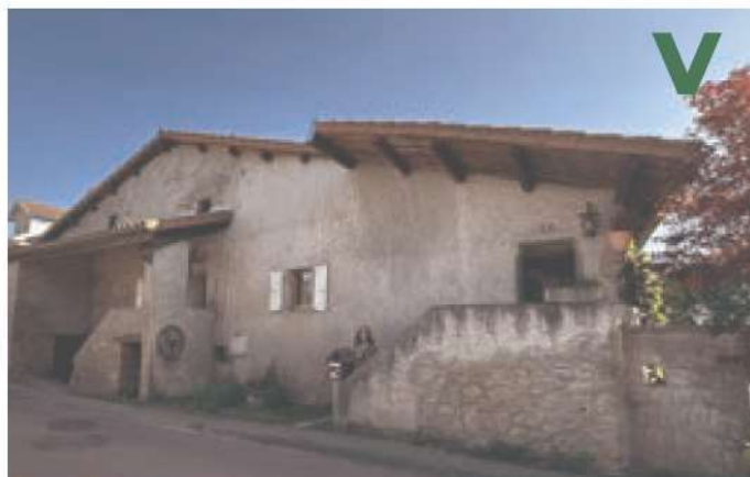
Chez Moachon. Escalier maçonnée pour accéder aux pièces de vie.
