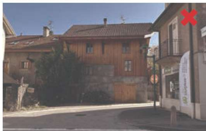
Bons-en-Chablais. L'enduit a été substitué par du bardage bois en partie haute et de l'enduit ciment en partie basse.
