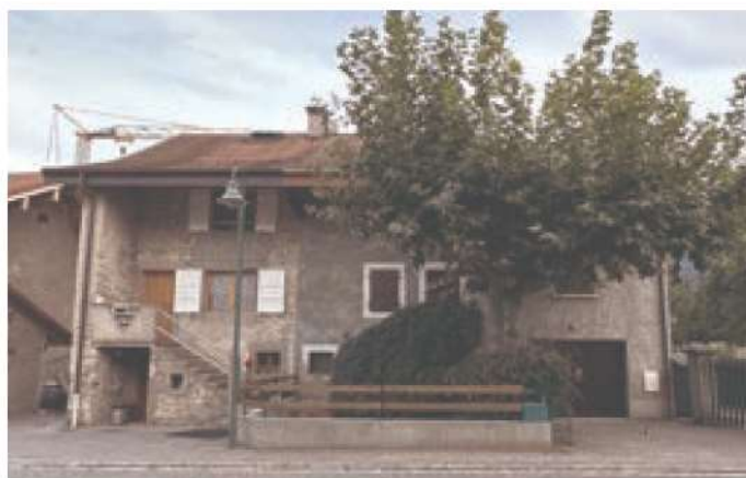
Maison rurale avec escalier et accès à la cave, Brens.
