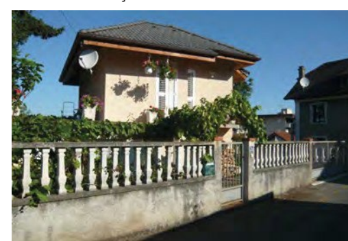
Mur maçonné surmonté d'éléments en serrurerie et doublé de végétal
