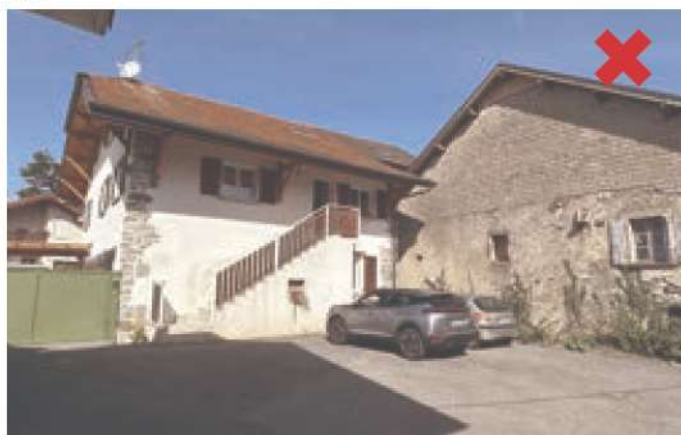
Loyer d'en haut. L'ancien garde-corps en ferronnerie était substitué par un garde-corps en bois pour faire "rustique".
