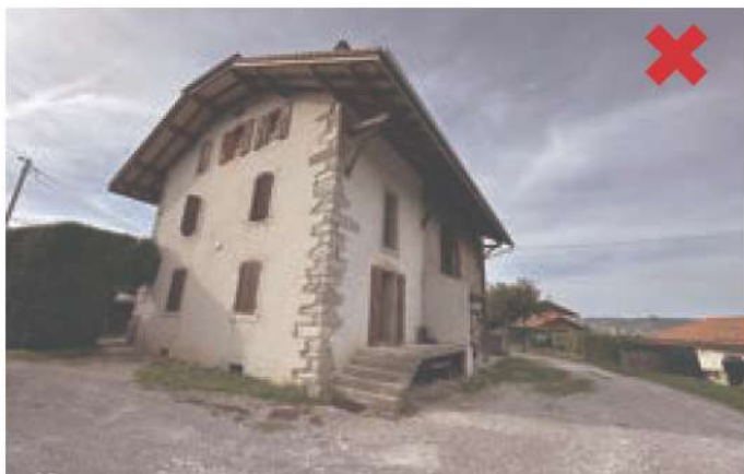
Langin. Chaînage d'angle avec enduit en sur-épaisseur
