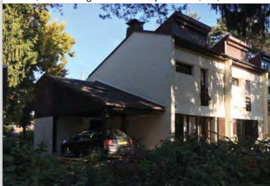
Construction appuyée en pignon
