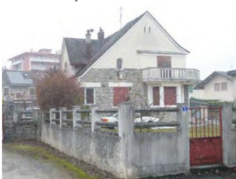
Muret en béton surmonté d'éléments en serrurerie à dessin géométrique et barreaudage vertical
