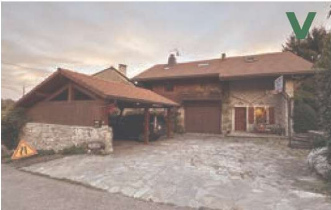
Les Granges. Extension type carport qui est de taille plus modeste et détachée du bâti principale
