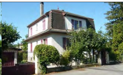
N°2 VILLA 1936 : toiture mansardée à brisis avec lucarne droite, oriel arrondi à 3 pans surmonté d'une verrière couverte avec marquise en fer et verre, tuiles écailles, volets bois Niveau de protection contrôlée
