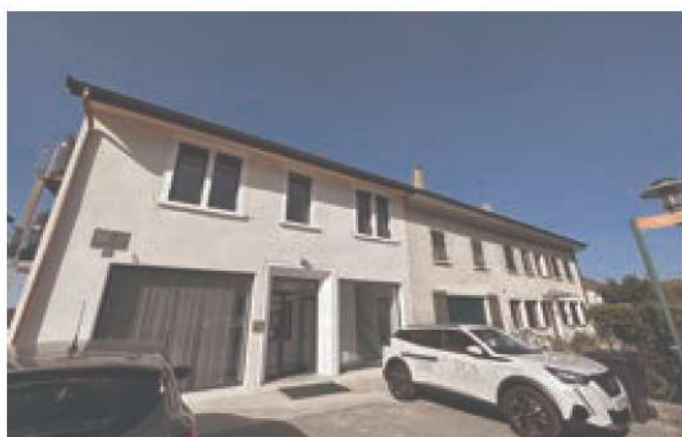
Maison traversante avec commerce, Bons-en-Chablais centre
