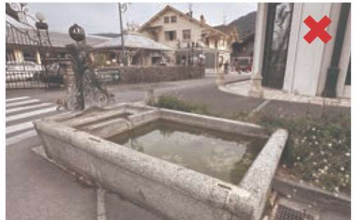
Langin. Bassin positionné dans un élargissement du trottoir mais qui ne donne pas lieu à un espace de convivialité.
