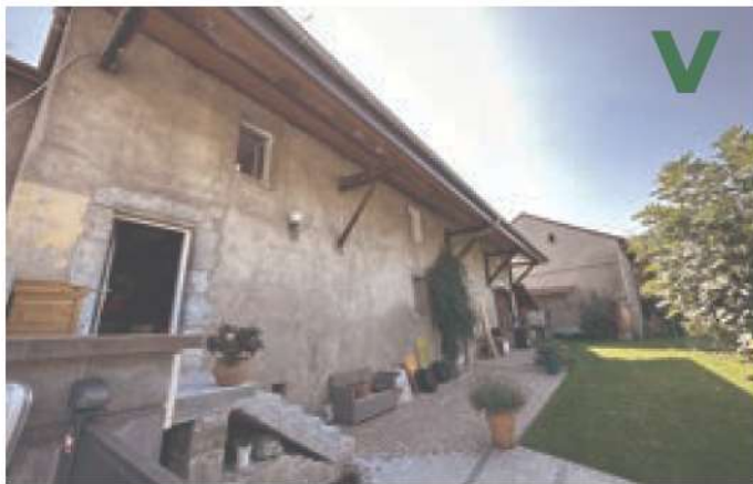
Loyer d'en bas. Création d'une terrasse au rez-de-chaussée
