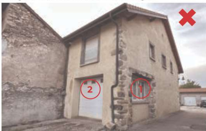
Brens. L'ancienne porte a été modifiée avec la création d'une fenêtre en bandeau et une allège pleine (1). Une nouvelle porte de garage a été percée (2) et une porte de grange a été transformée en porte de garage basculante (3).
