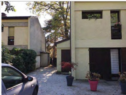
Espace entièrement minéralisé, absence de végétal : interdit
