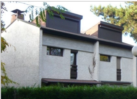
Linteaux béton brut
