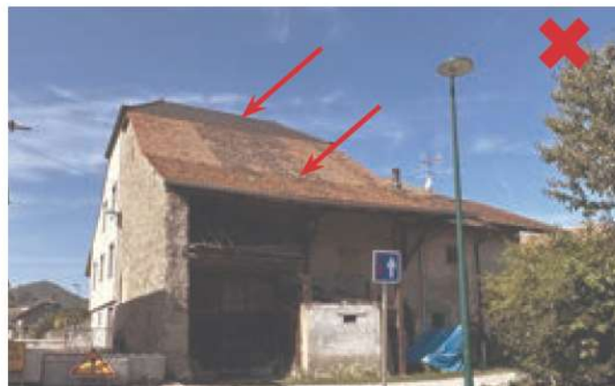
Bons-en-Chablais. Exemple de toiture qui présente deux matériaux différents sur le même pan.
