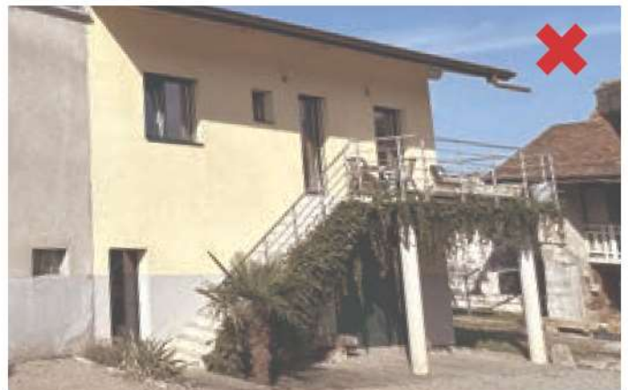
Loyer d'en haut. Création d'un escalier en béton avec terrasse soutenue par deux piliers en bétons
