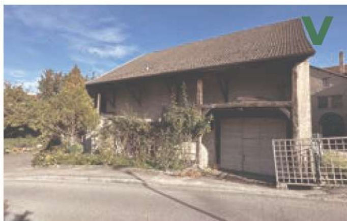
Bons en Chablais. Toiture sans ouvertures et belles passées de toiture
