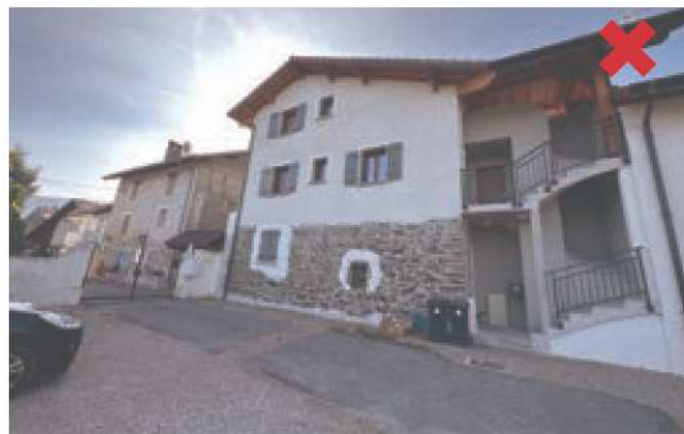
Saint Didier. Sous bassement en pierre apparente et pied de bâtiment recouvert en ciment.
