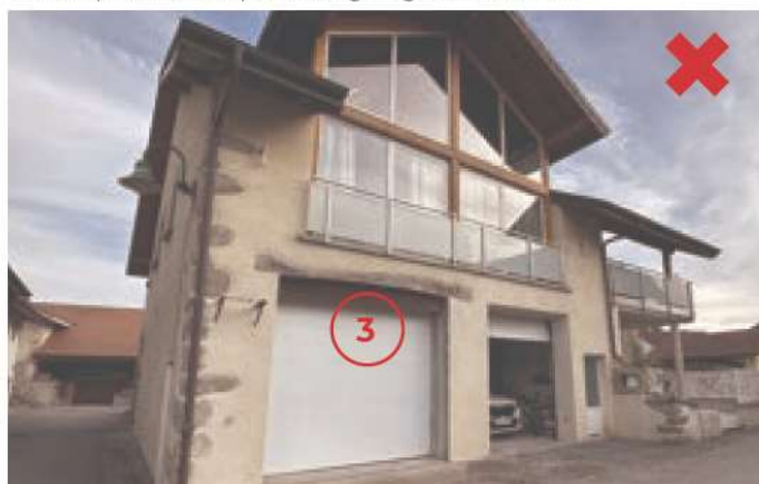
Brens. L'ancienne porte a été modifiée avec la création d'une fenêtre en bandeau et une allège pleine (1). Une nouvelle porte de garage a été percée (2) et une porte de grange a été transformée en porte de garage basculante (3).
