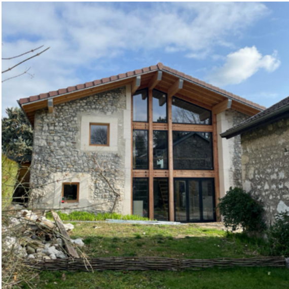
Restructuration d'une grange en vue de la transformer en habitation Sergy
