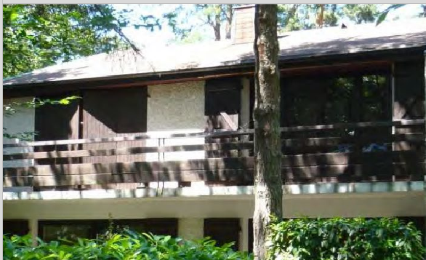
Contrevents à double lambris sur écharpe en Z, teinte brun-foncé
