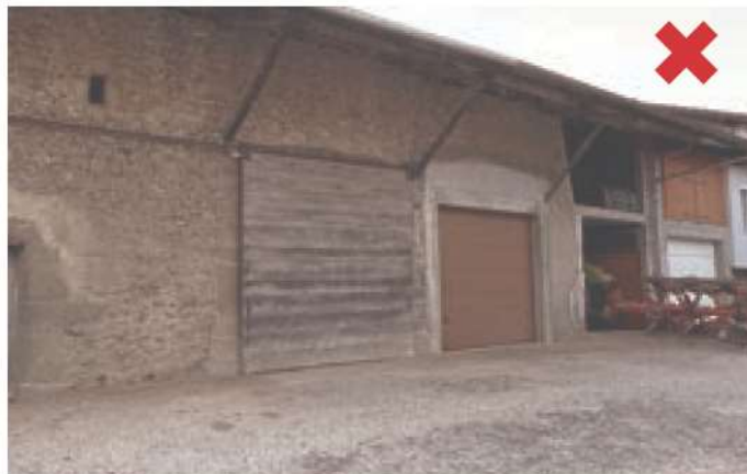
Brens. Réduction de la porte de grange d'origine en béton et mis en place d'une porte de garage basculante.
