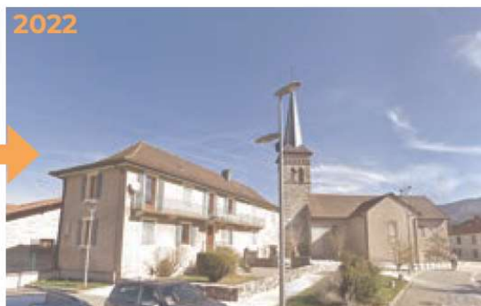
Saint-Didier. Le couronnement de l'église a changé et le mur en pierre a été déposé pour créer un espace plus ouvert. Sur le bâtiment de gauche on note l'ajout des velux en toiture, la création d'un balcon au 1er étage et des portes fenêtres pour y accéder.
