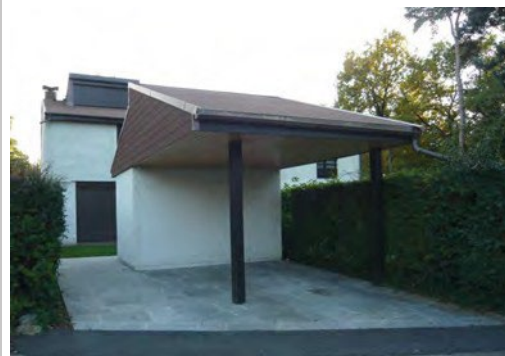
Construction avec annexe rangement
