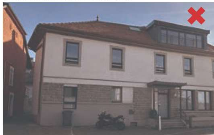
Bons-en-Chablais. Lucarne rampante très grande pour éclairer les combles. Le seul velux n'est pas en alignement des baies.
