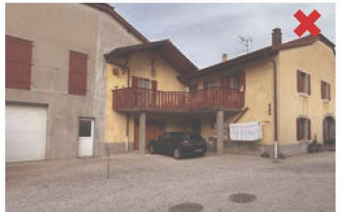
Brens. Création d'un balcon avec une structure béton et garde-corps en bois complètement incohérent.
