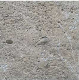
Conservation des enduits anciens Restauration des enduits anciens à la chaux
