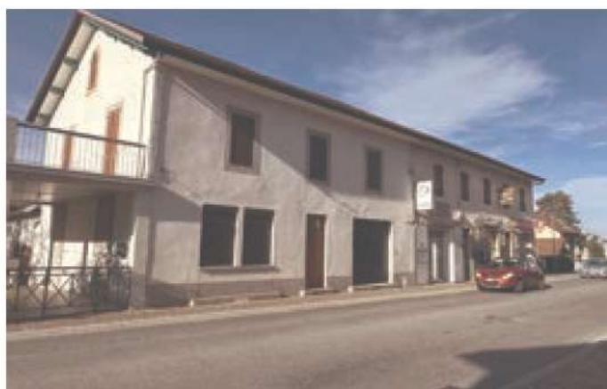
Maison traversante avec commerce, Bons-en-Chablais centre
