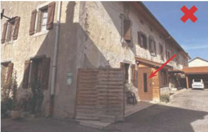
Saint Didier. Création d'une protection de l'entrée hors échelle et avec un pastiche de matériaux différents.
