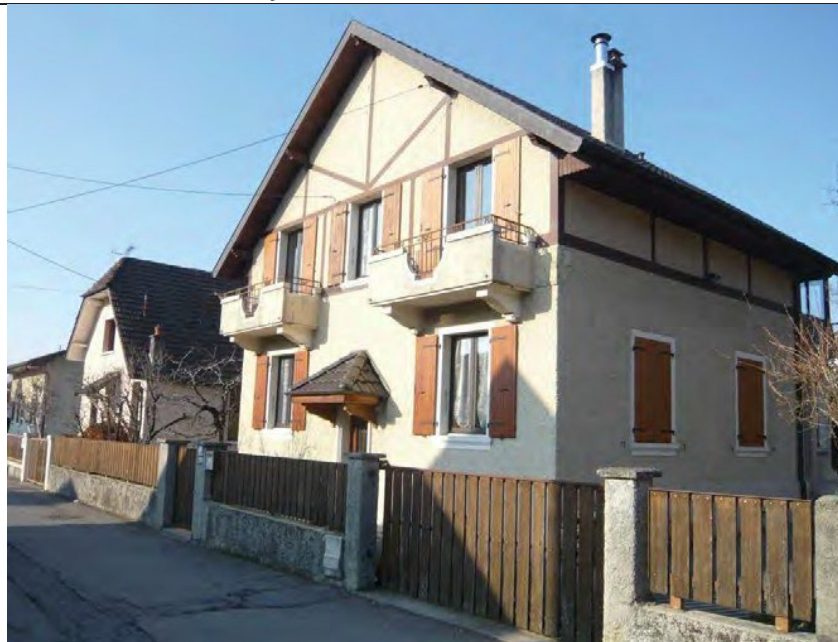
Murs maçonnés surmontés d'une clôture lattis bois
