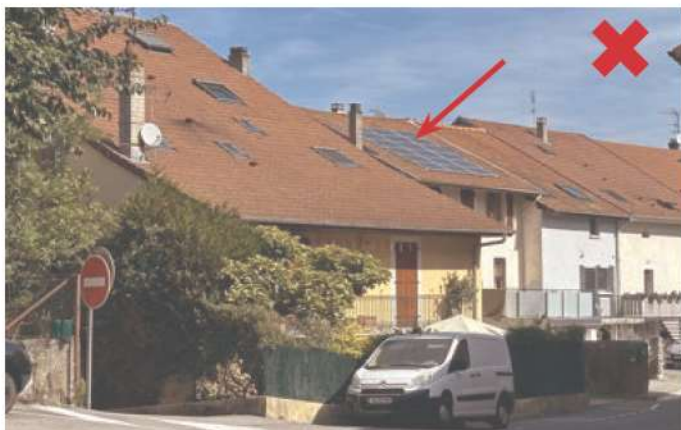
Bons-en-Chablais. Le pan de toit en premier plan présente trop de velux. L'intégration des panneaux solaires est à questionner.
