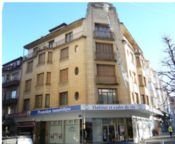
Angle rue des Vieux Thononais / Square Aristide Briand
