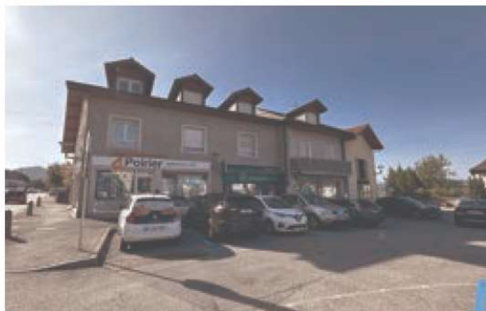
Maison traversante avec commerce, Bons-en-Chablais centre
