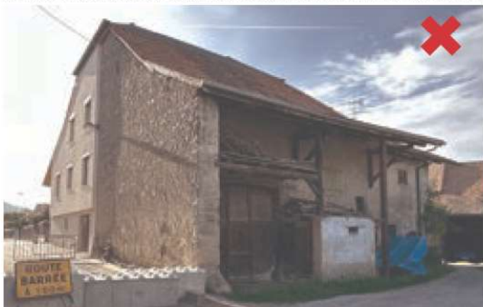
Bons-en-chablais. Exemple de réhabilitation énergétique qui a créé un effet champignon entre le bassement non isolé et les étages. De plus, l'écriture architecturale des menuiseries et des BSO a complètement changé le patrimoine
