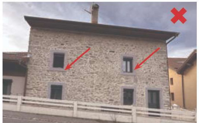
Brens. Suppression des volets bois (gonds encore présents) et mise en place de volets roulantes.
