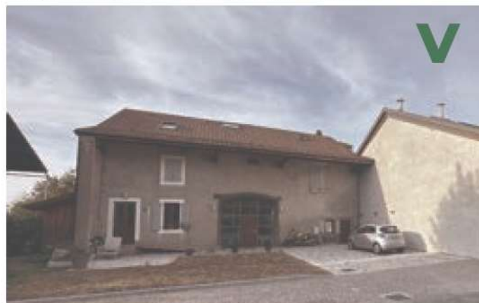
Le Choulex. Exemple de porte de grange réhabilitée avec partie centrale opaque et périmètre vitré
