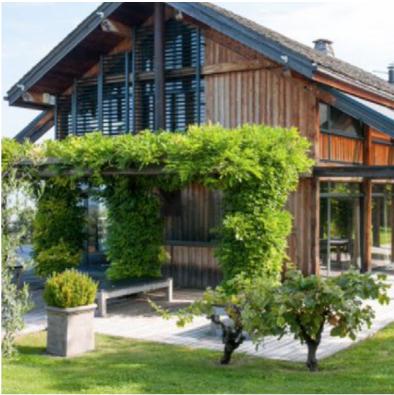
Construction d'une grange contemporaine Publier Volumes simple / Prolongation des chevrons afin d'intégrer une pergola / Construction en ossature bois
