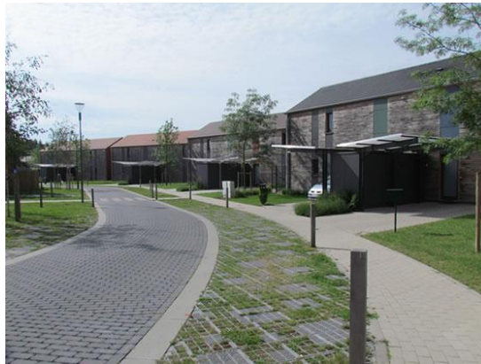
Exemple de stationnement perméable ©O2D Environnement
