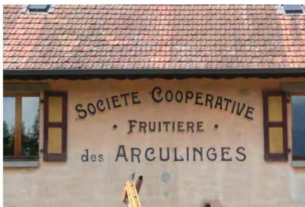
Un patrimoine bâti à préserver
