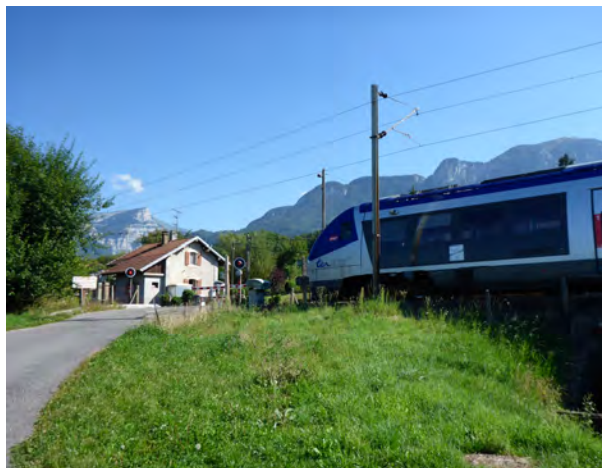
Passage d'un TER sur la ligne existante
