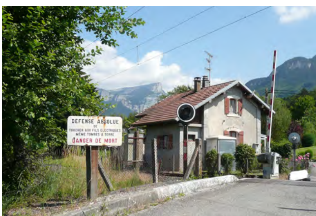
Un patrimoine bâti à préserver
