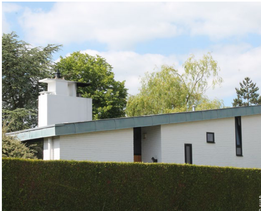
Détail de toiture et la composition des cheminées
