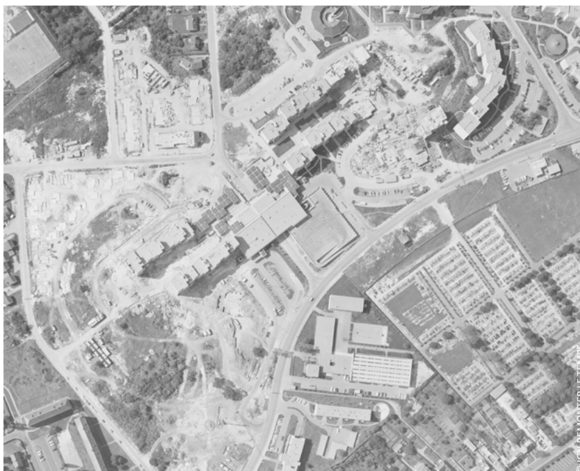
Vue aérienne du quartier en 1979. La majeure partie des immeubles de l'Allée des Rencontres a été construite. Les deux collectifs « G2 Innovation » et le Parc d'Assas sont en cours de chantier
