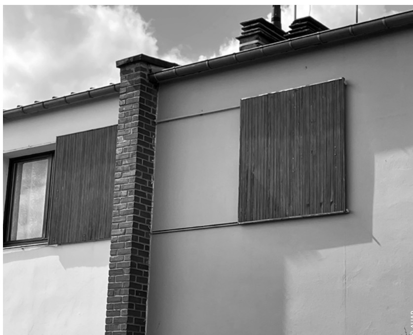
Détail sur les volets coulissants et leur rôle majeur dans la composition des façades
