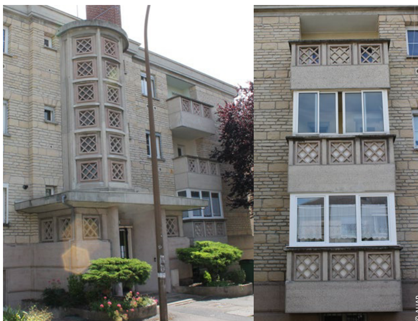
Détails sur les cages d'escaliers et les garde-corps
