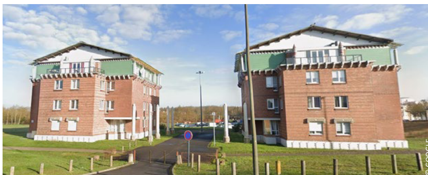
Immeubles de la rue Picasso, Vallée St-Ladre, 1987
