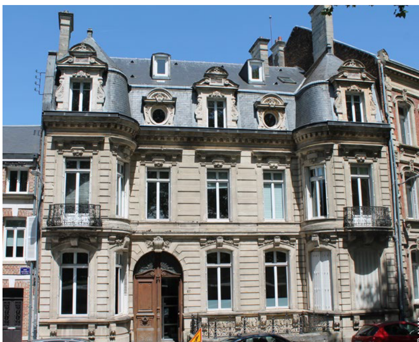
Exemple d'un hôtel particulier avec éléments galbés et bossages, centre-ville
