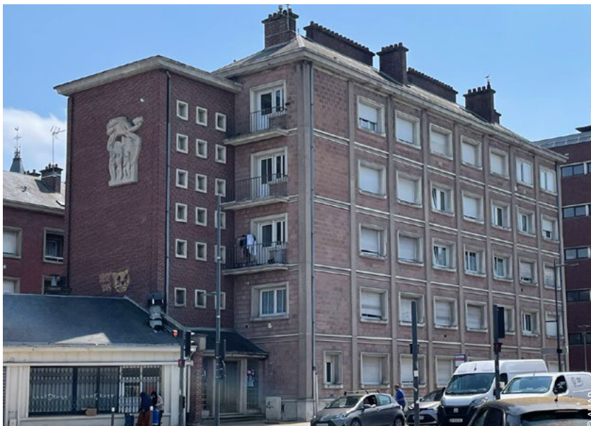
Les immeubles en symétrie de la Place Vogel, composés d'agglomérés de briques concassées, et ses bas-reliefs
