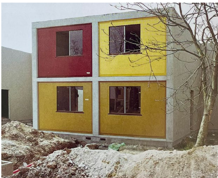
Vue sur les panneaux «Arlequins» d'origine en 1972
