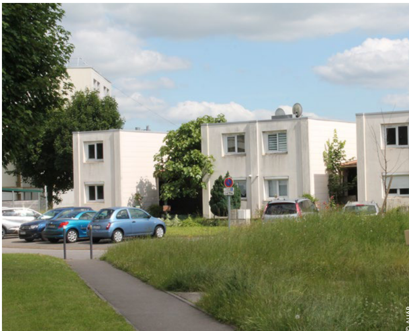
Vue sur l'habillage des façades, datant de 1985
