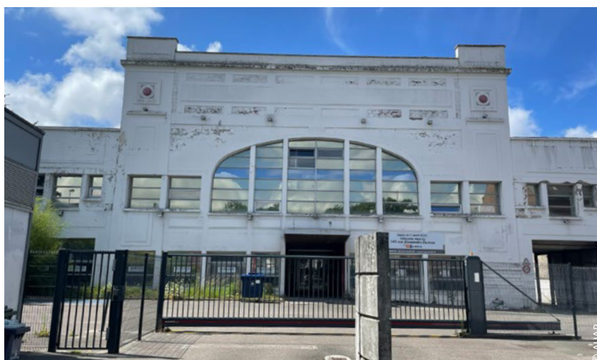
L'ancien garage situé au 500 Avenue du 14 Juillet 1789
