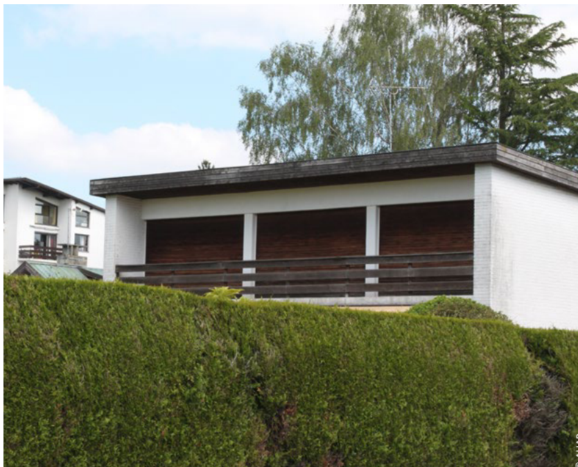
Détail des lames de bois formant garde-corps
