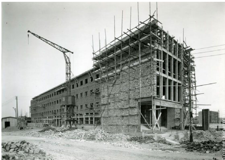
Vue du chantier, années 1950
