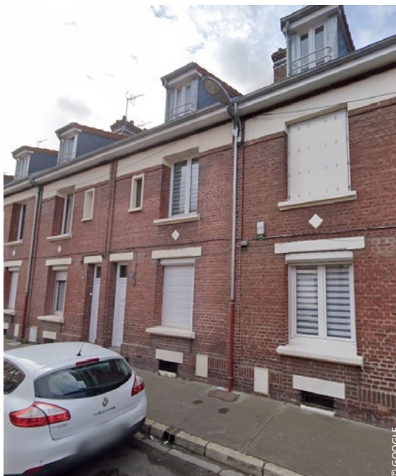
Les arcs font place progressivement aux linteaux béton
