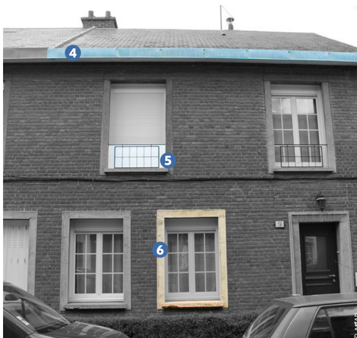
Une maison individuelle de la reconstruction
