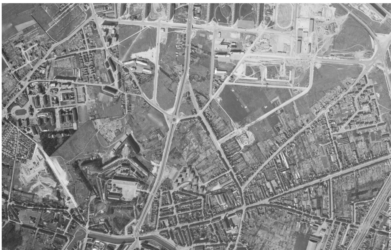
Le Pigeonnier en cours de construction, photographie aérienne, 1965
