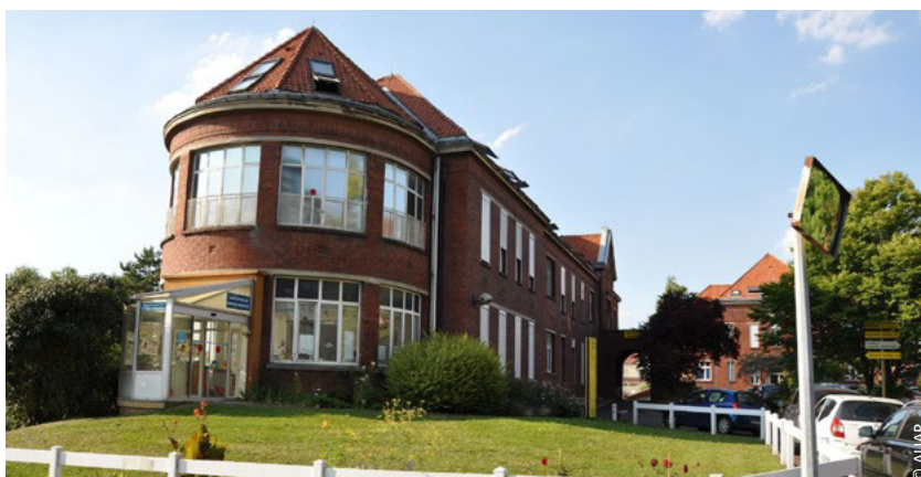
Vue de l'un des anciens pavillons de soins pédiatriques
