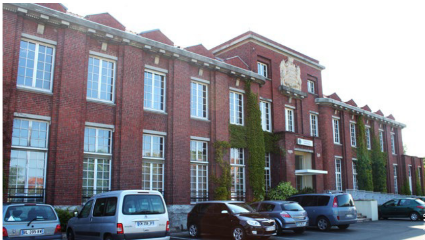
Vue du pavillon de direction
