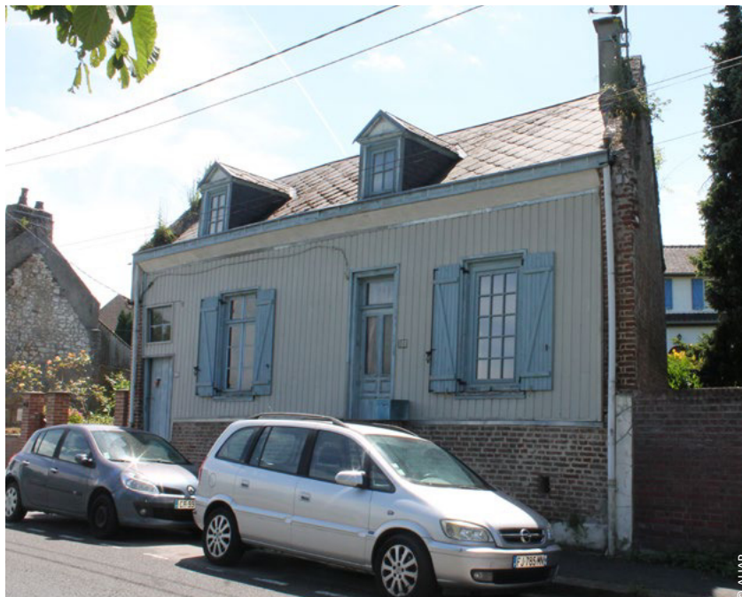
Une maison à pans de bois dans le quartier La neuville
