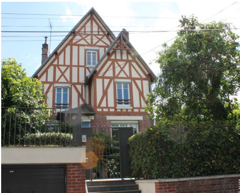
Traitement des façades en « pans de bois »
