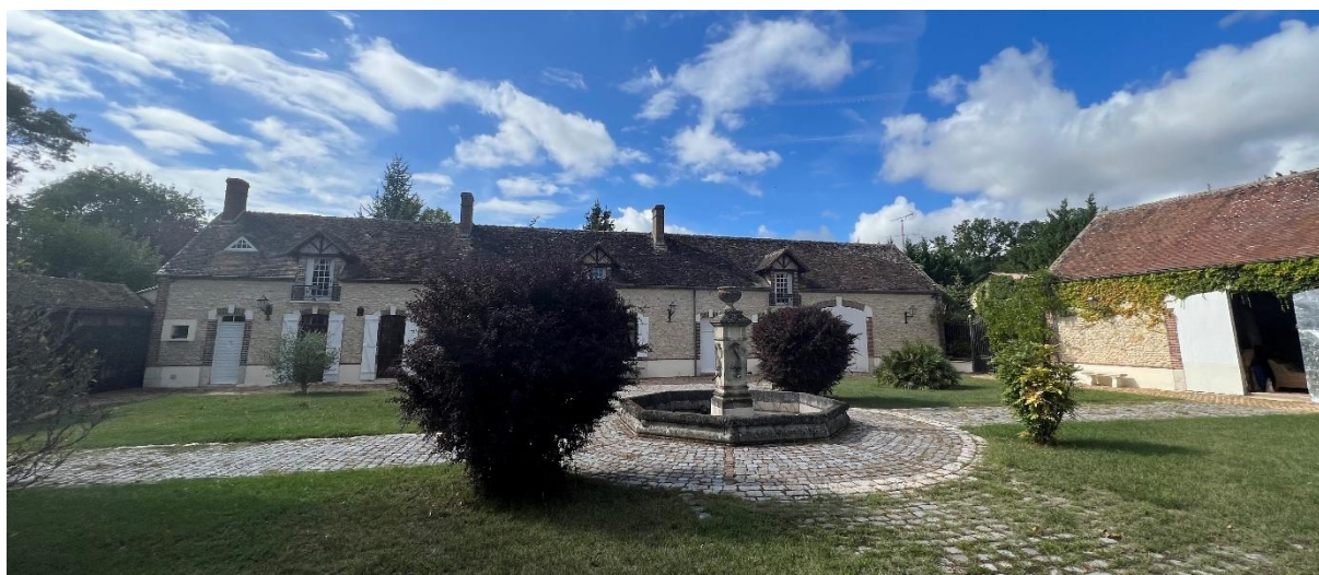
Figure 9 - Vue sur le bâtiment principal
