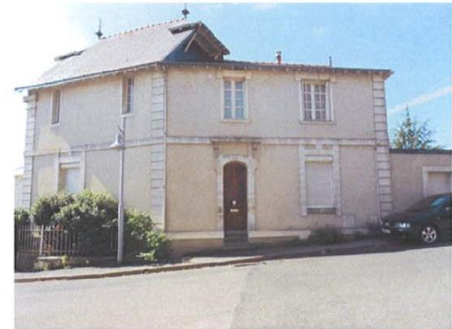
angle n°13 Rue des Quais
