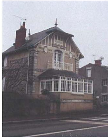
angle n°13 Rue des Quais
