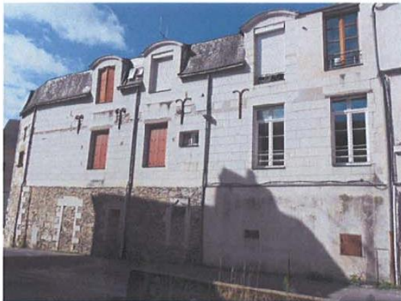
Façades liées avec le n°50 Rue des Tonneliers
