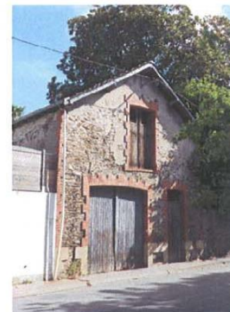
Façade à côté du 140
