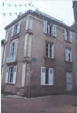
n°7 rue Tartifume
