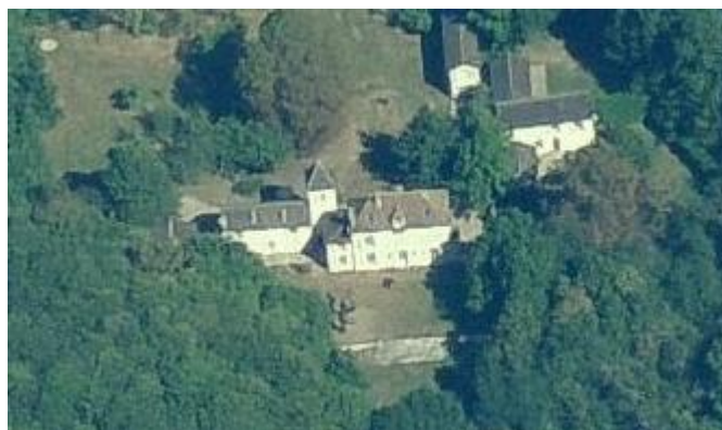
Château du Bel Air Source photographie : google maps
