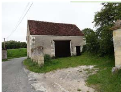
31 Bâtiment Theret Gonzales Mai 2017
