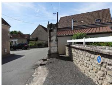
53 Le puit collectif Rue du commerce -mai 2017
