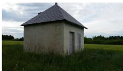
59 loge de vigne restaurée
