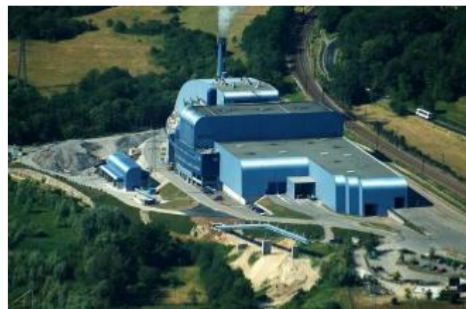
Usine de Valorisation Énergétique du SIDEFAGE
