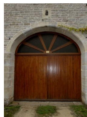
Porte pleine et imposte vitrée - Arc cintré
