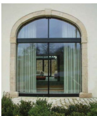
Porte vitrée - Arc cintré
