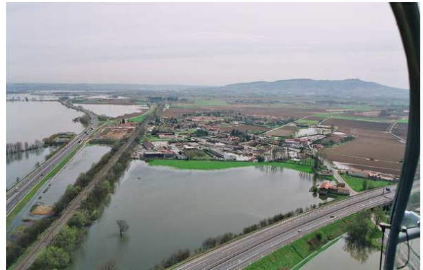
Ambérieux, crue de 2001
