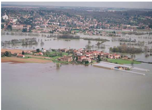
Quincieux, crue de 2001
