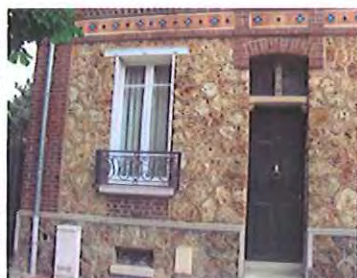
Garde-corps, persiennes et linteau métalliques
