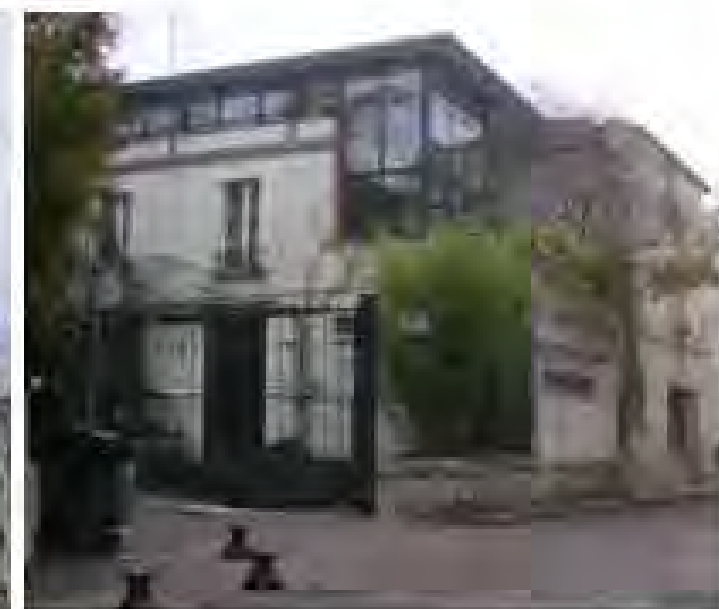
Clamart, rue Chef de Ville : extension et surélévation d'une maison 19 ème très respectueuses de la construction pré-existante
