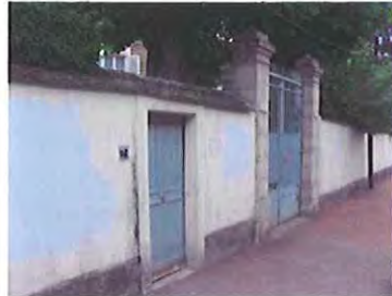
Haut mur en maçonnerie enduite
