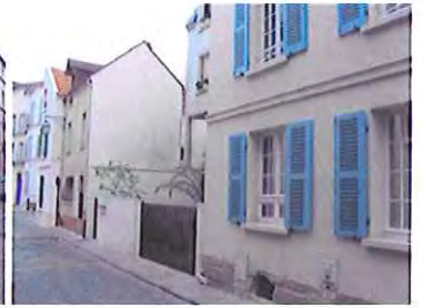
Rupture de la continuité du front bâti
