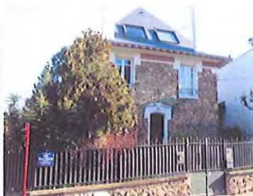
Fenêtres de toit surdimensionnées
