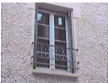
Pose en rénovation de menuiserie PVC
