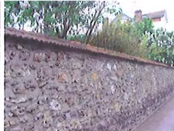
Haut mur en maçonnerie apparente
