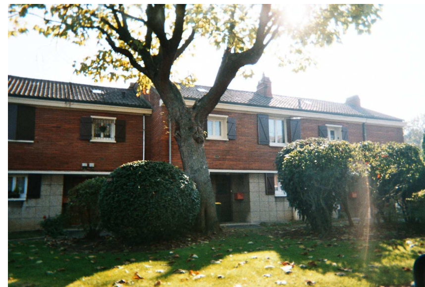
Maison individuelle en bande : différenciation du soubassement en plaque d'agrégat + corps de façade en brique, encadrement des baies en béton
