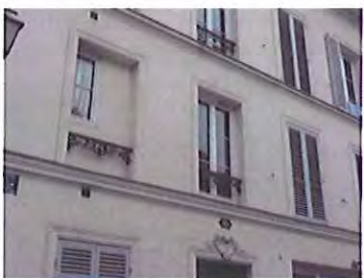
Hétérogénéité des menuiseries
