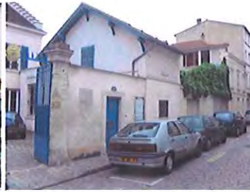
Bâti et haut mur de clôture
