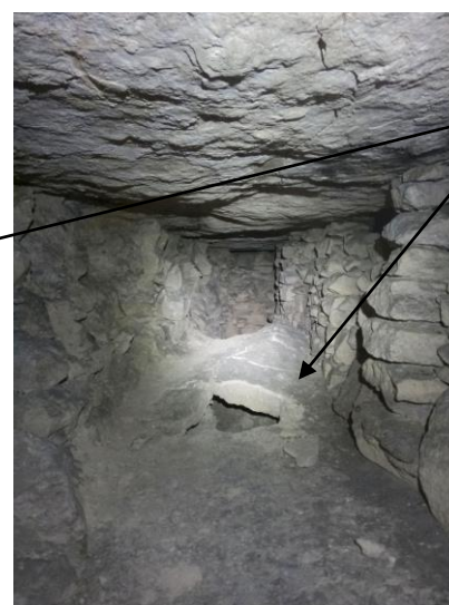
Photo 8 : banc séparatif cassé entre étages, sous la rue Etienne Desforges (Photo IGC AML)
