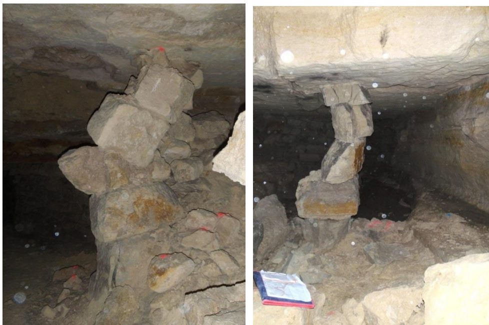
Photo 13 : exemples de tassement général d'une carrière entraînant la dégradation des piliers à bras – techni-centre (photo AML-IGC)
