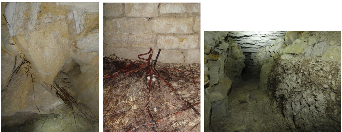
Photo 15 : exemples de racines en carrière – dans un étau de masse, dans un puits ou dans des remblais (photo AML-IGC)
