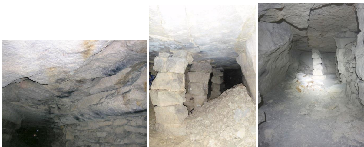
Photo 12 : exemples de cassure du toit en front de taille - sous le technicentre SNCF et la rue de Paris à Châtillon (photo AML et JQ - IGC)
