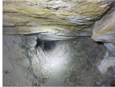
Photos 17 : ciels de carrière en mauvais état dans une zone où le Banc de Roche a été exploité – rue de Paris (Photo IGC-2015)
