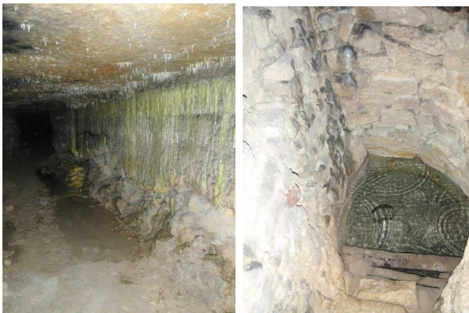
Photo 2 : infiltrations d'eau vers la nappe du Lutétien et puits à eau en carrière à Châtillon (photo AML-IGC-2012)
