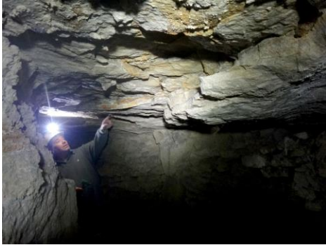
Photos 17 : ciels de carrière en mauvais état dans une zone où le Banc de Roche a été exploité – rue de Paris (Photo IGC-2015)
