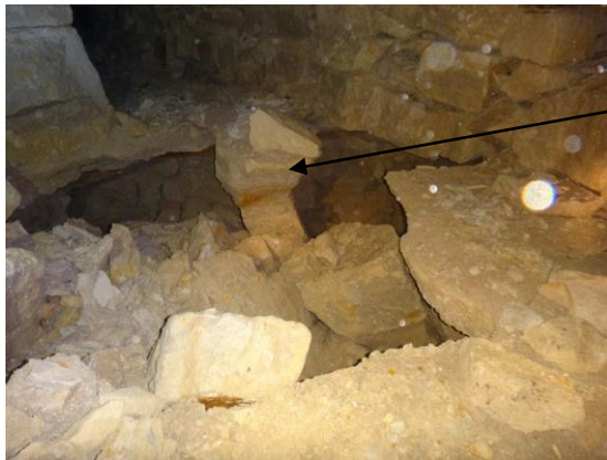
Photo 6 : éclatement du banc séparatif et poinçonnement de ce banc par un pilier à bras de l'étage inférieur à Bagneux (photo AML-IGC)
