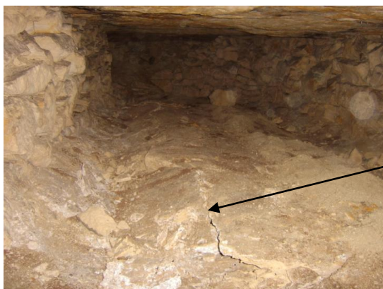
Photo 7 : Tassement et cisaillement du sol sous l'effet de la non-superposition des hagues et de poinçonnement de l'étage moyen pr l'étage supérieur – Châtillon (Photo AML-IGC)
