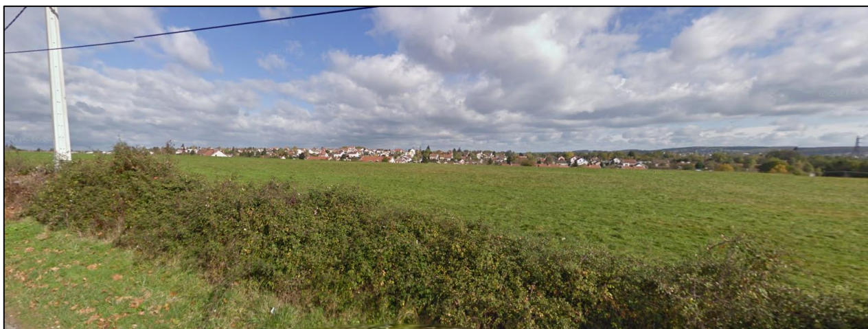
Vue de la zone AU du Bois Garnier depuis l'Ouest
