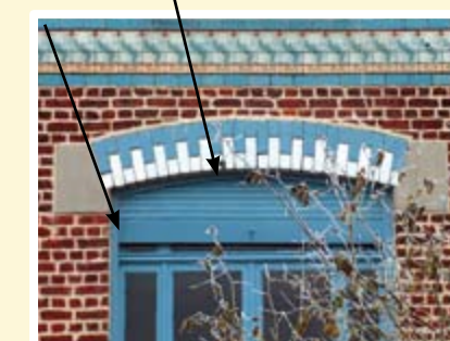
volet roulant avec caisson intégré à la maçonnerie
