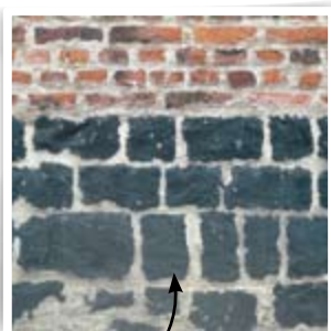
soubassement en pierres dures peint
