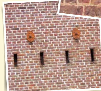
joints blancs à la chaux
