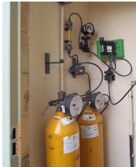
Illustration n°3 : Système de traitement au chlore gazeux
