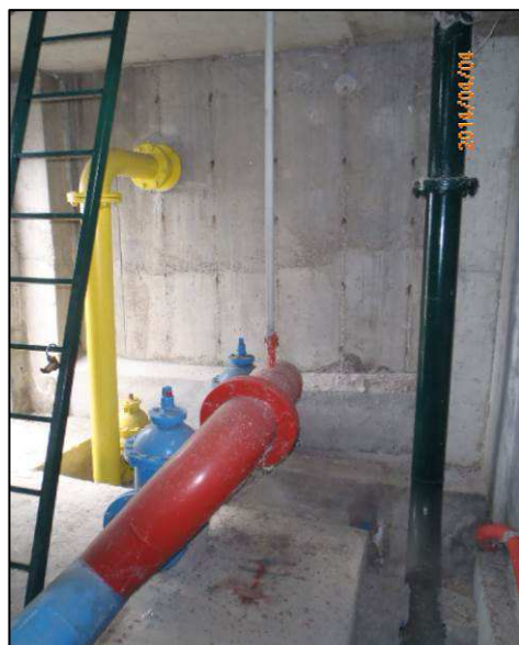
Illustration n°8 : Chambre de vannes du réservoir du Belvédère
