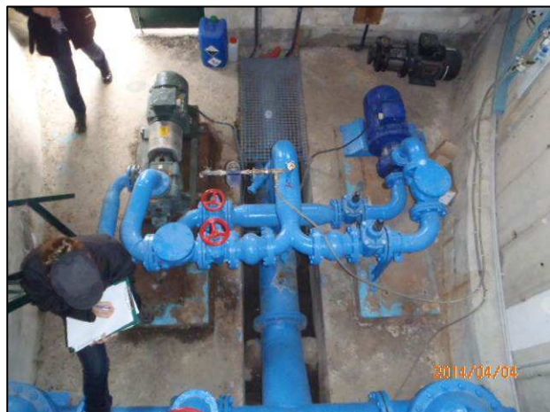
Illustration n°5 : Chambre de vannes du réservoir de Saint Martin
