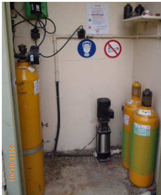
Illustration n°3 : Système de traitement au chlore gazeux
