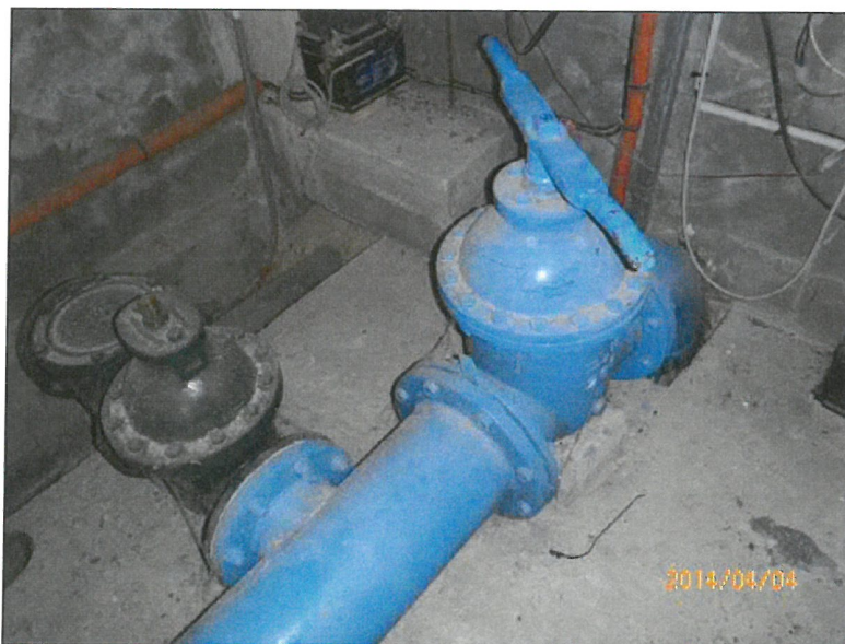
Illustration n°8 : Chambre de vannes du réservoir du Belvédère
