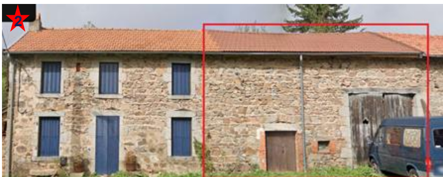
Repérage d'une ancienne grange accolée à une habitation située 31, rue des Verriers, cadastrée AC 32. Zone A du PLUi.
