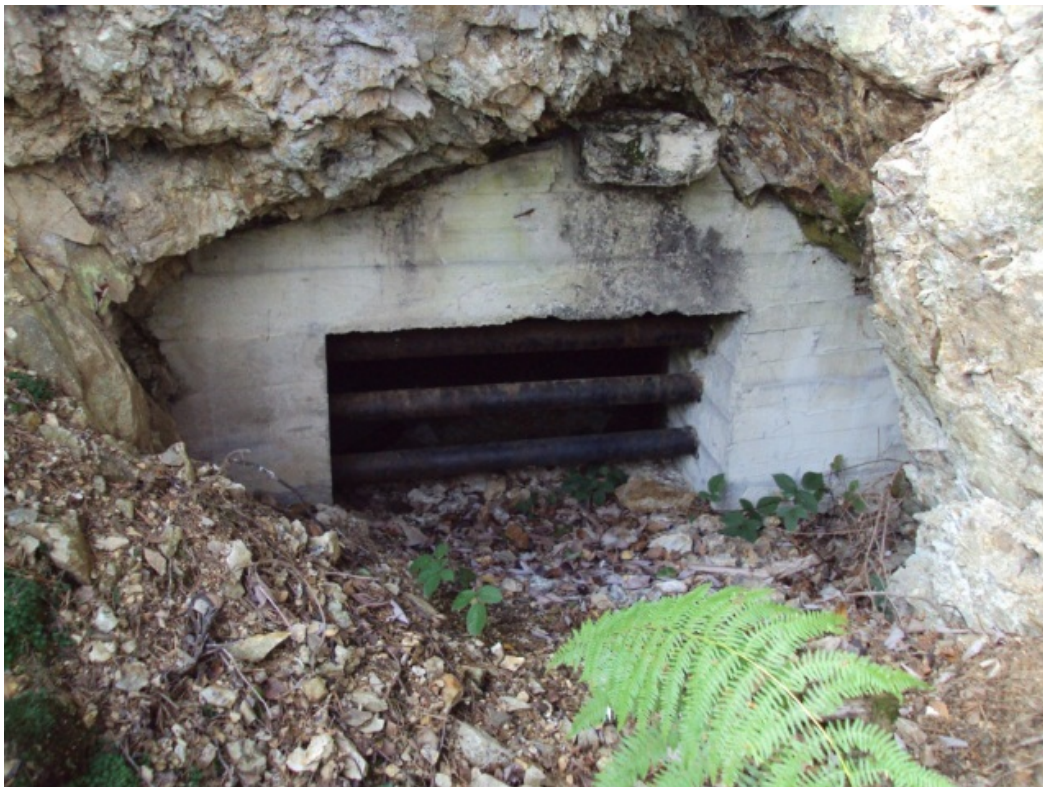
Photo 7 : Galerie 2 du Chatelard G9 – cote 751
