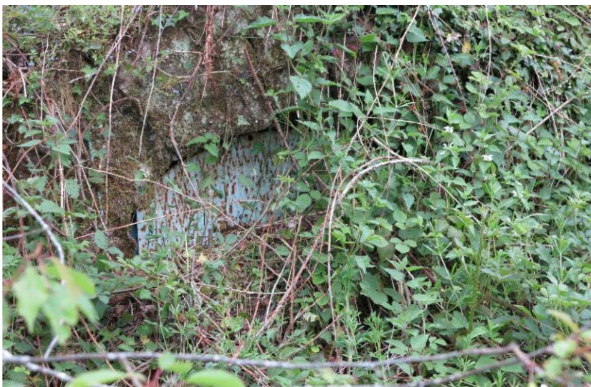
Photo 3 : Galerie d'écoulement G2 – cote 650
