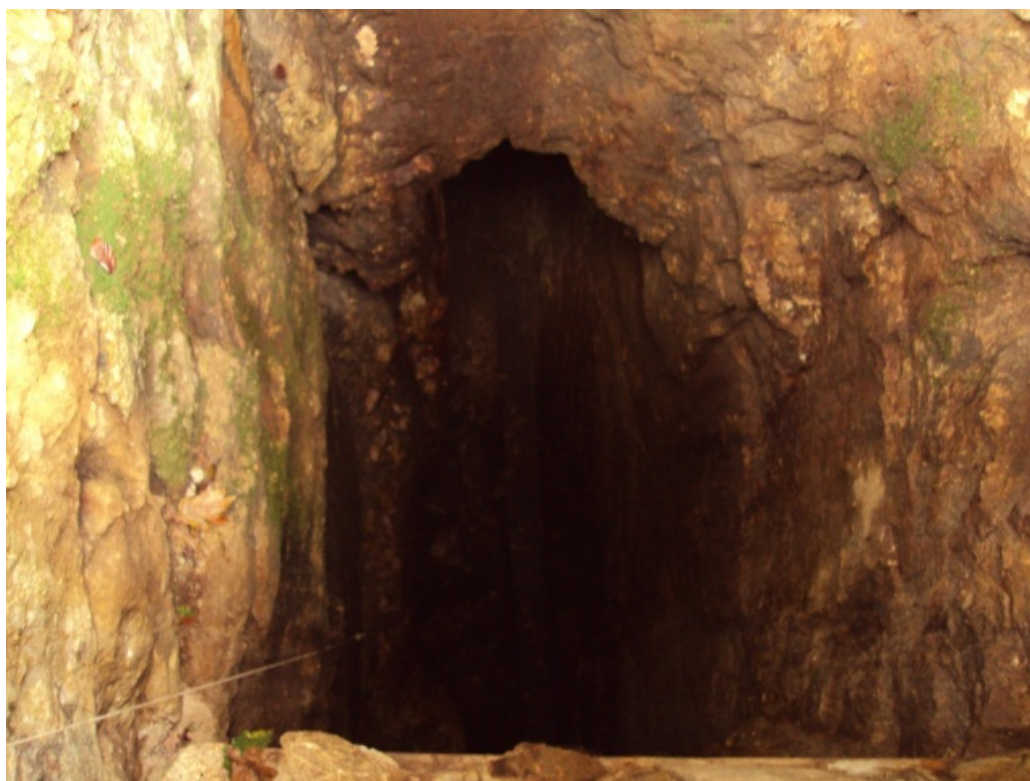
Photo 26 : Puits 2 Ramillard P14
