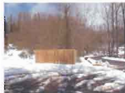
Intégration des conteneurs en bas du château
