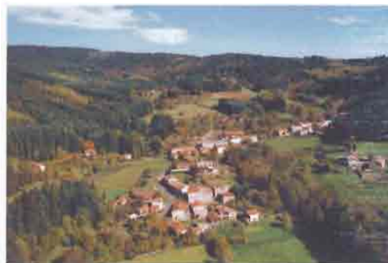
Source : Vues d'hélicoptère – M. ITOURNEL
