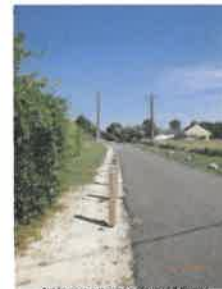
Aménagement chemin BAZOUIS à PUYO
