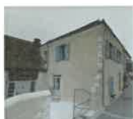
Exemple de construction réhabilitée à Morlaix
