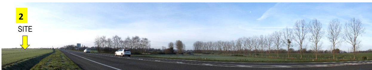
Vue sur la RN162 depuis le Nord du périmètre : alignements d'arbres en limites de parcelles
