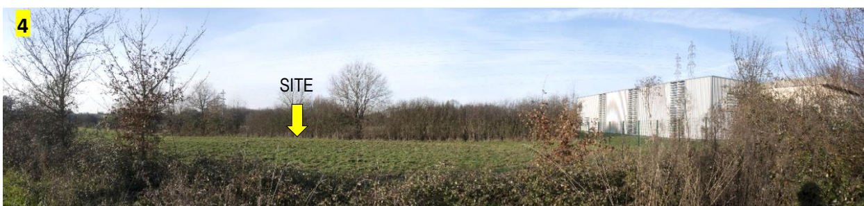
Vue sur le site et les clôtures de l'activité en place. L'absence d'accompagnement végétal à ce jour nuit à l'insertion paysagère de la construction dans le site
