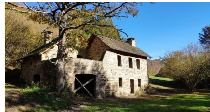
Vue sur la maison existante - photographie prise depuis l'Ouest du site)
