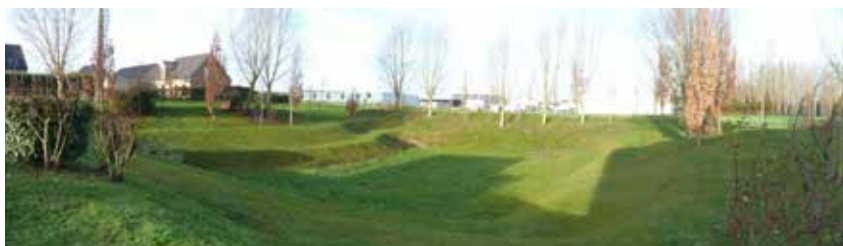
Bassin de rétention au sud du site 1
