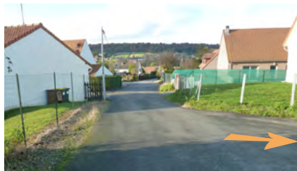
Accès depuis l'allée Paul Allard
