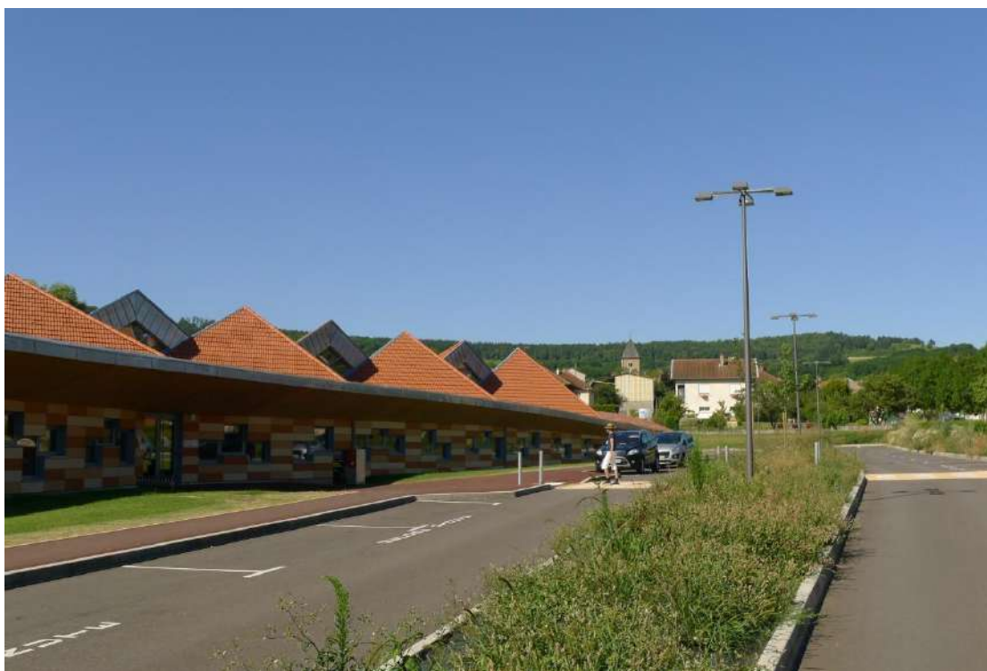
Ensemble scolaire de Jeandelaincourt avec toiture recouverte des fameuses tuiles.
