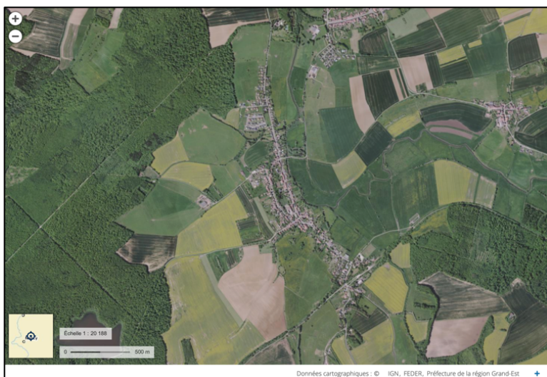
Brin-sur-Seille, vue aérienne 2018, Géoportail. Les extensions récentes de la commune sous forme pavillonnaire le long des axes routiers en direction du Nord et du Sud ont conforté son tracé.
