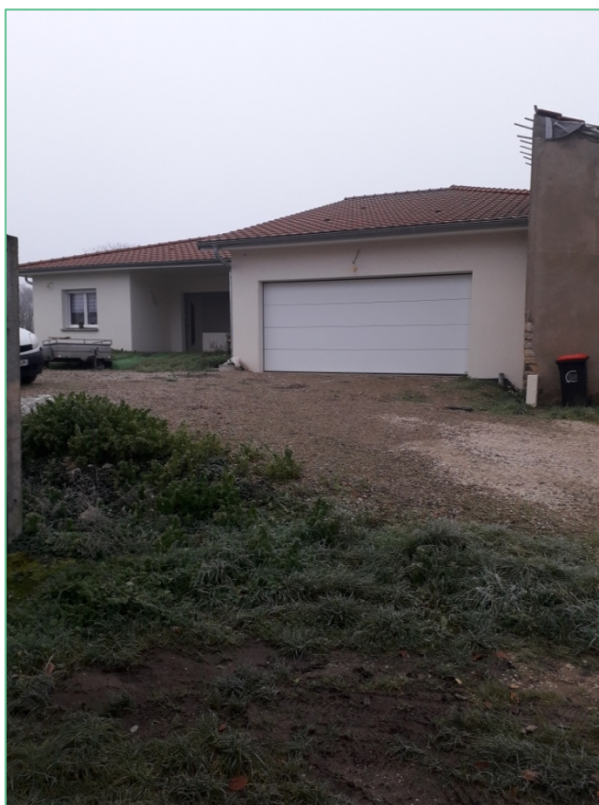
Construction achevée sur les parcelles 293/294 section E, Brin-sur-Seille
