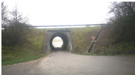
Passage sous tunnel faisant le lien entre la partie nord et Sud de la RN141
