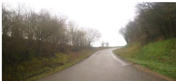
Route remontant du tunnel vers la Route de Tarsac
