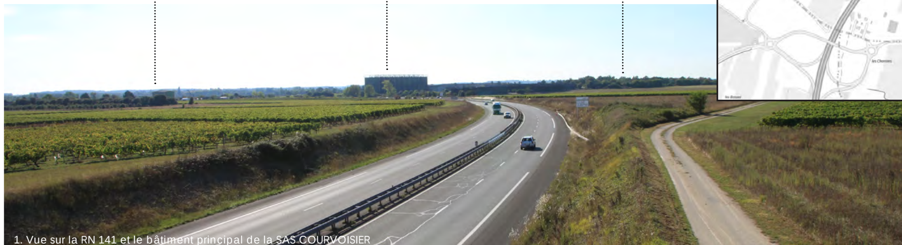
1. Vue sur la RN 141 et le bâtiment principal de la SAS COURVOISIER
