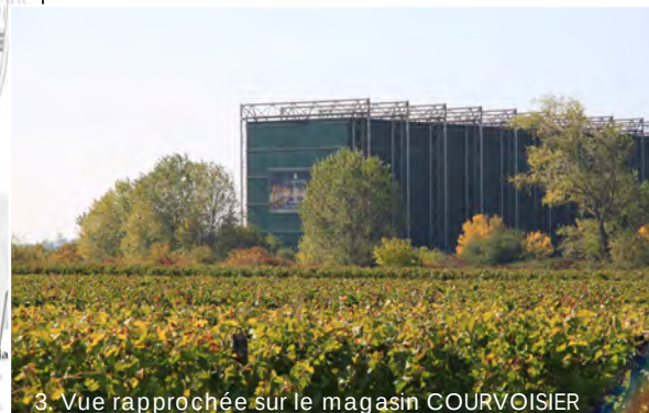
3. Vue rapprochée sur le magasin COURVOISIER
