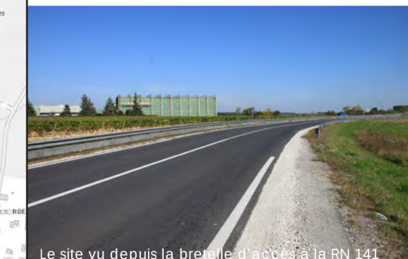
Le site vu depuis la bretelle d'accès à la RN 141
