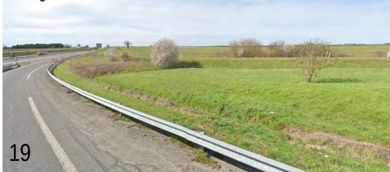
Depuis la voie d'insertion de la RN141, très léger filtre végétal arbustif le long du site - GSV
