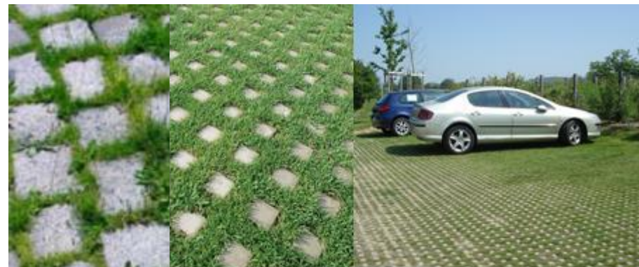
Exemples de traitement respectueux de l'environnement : pavés enherbés favorisant la perméabilité des sols
