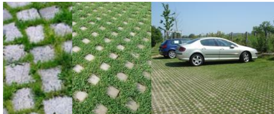
Exemples de traitement respectueux de l'environnement : pavés enherbés favorisant la perméabilité des sols
