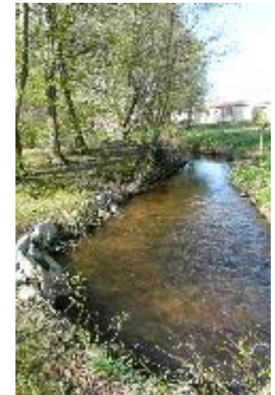
enrochement permettant de stabiliser les berges du pont
