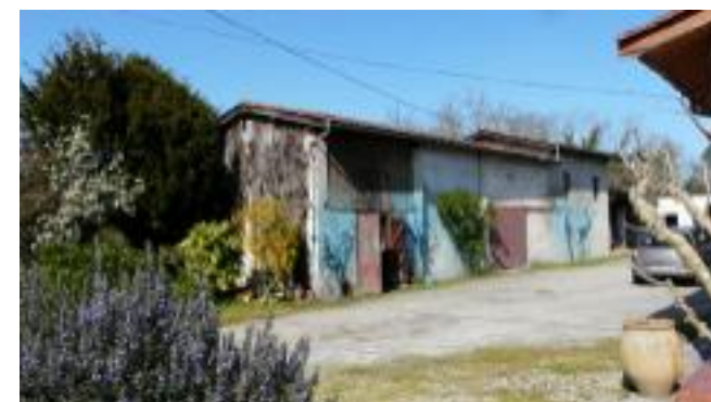
vieux hangar au sein du tissu pavillonnaire densifié, sur l'ancienne pâture
