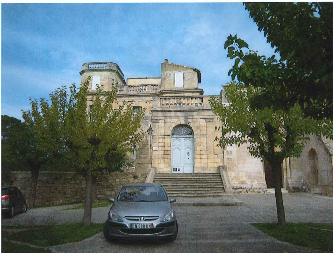
Photo 3 – L'entrée dans le château s'effectue par deux petites ailes (sud sur la photo) dans le prolongement latéral du logis. Ces deux corps d'entrée constituent les seules pièces voûtées du bâtiment.
