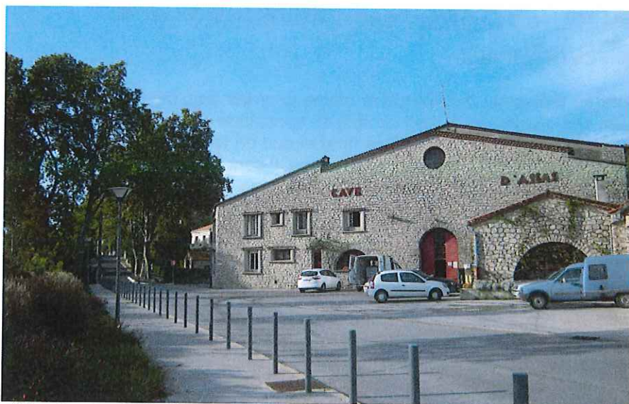
Photo 19 – Cave coopérative de l'architecte Rouquier, éligible au label du XXème siècle
