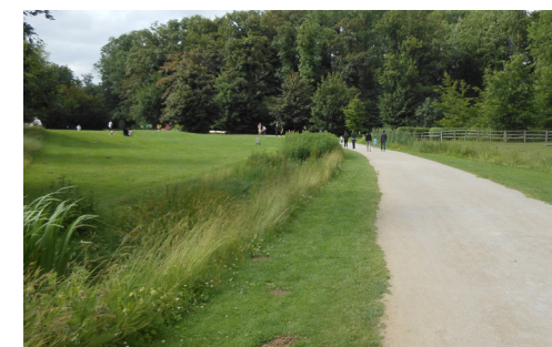
Exemples de traitement des noues et ouvrages hydrauliques
