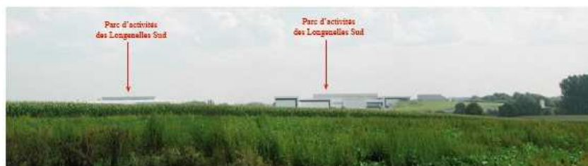
PHOTO 10 - Les perceptions visuelles en direction du Parc d'activités des Longenelles Sud sont également bien présentes depuis la façade Ouest du projet
