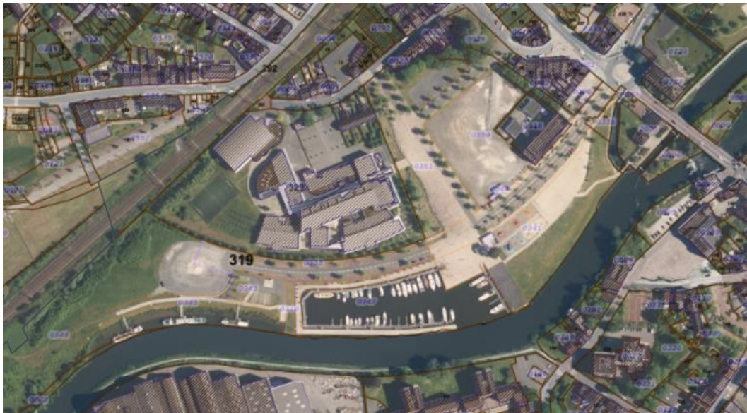
Figure 9: photo aérienne de la zone concernée - Géoportail
