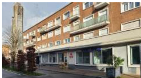
Linéaire commercial Avenue Franklin Roosevelt
