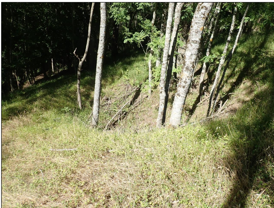
Photo 2 : Désordre D18 situé à l'aplomb de la galerie de la République sur la commune de Val-de-Sos
