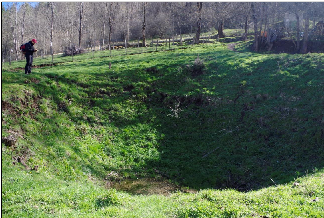
Photo 1 : Désordre D7 situé à l'aplomb de la galerie Becquey sur la commune de Val-de-Sos
