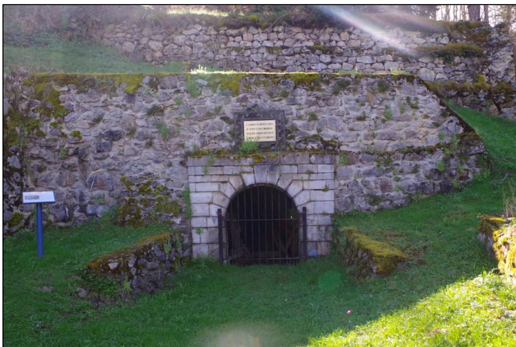
Photo 3 : Entrée de la galerie Becquey (ODJ n°10) sur la commune de Val-de-Sos
