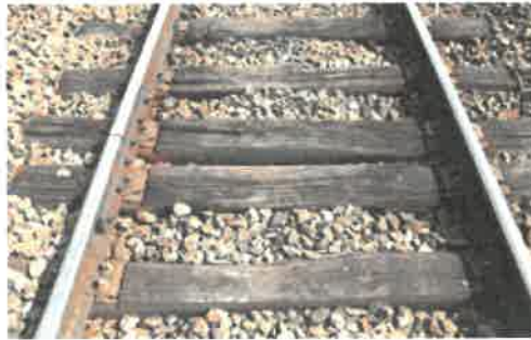
Rails courts sur traverses bois
