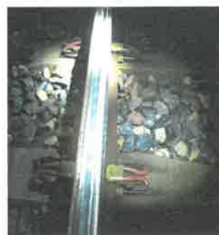
rail après meulage
