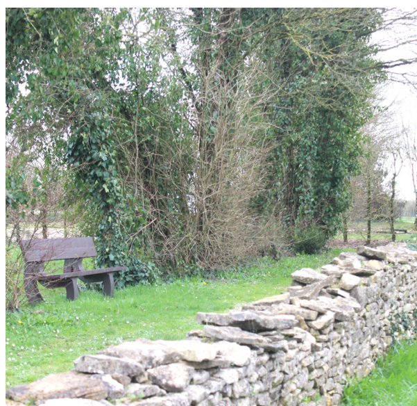
Installation d'un muret en pierre sèches
