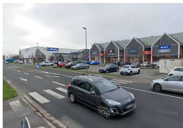
Zone commerciale de Ther (Beauvais/Allonne) - Google maps
