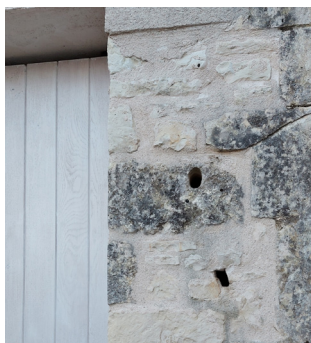
Trous dans murs en moellons
