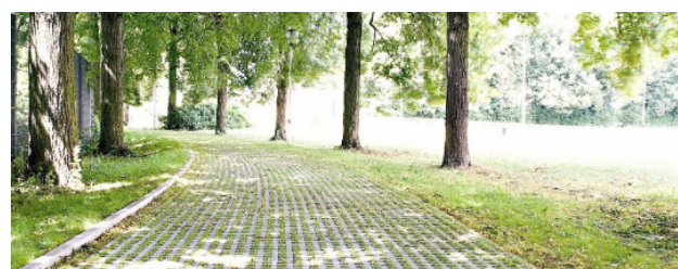
Revêtement de circulation douce semi-perméable
