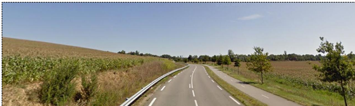
La RN 224, voie requalifiée pour le passage des transporteurs gros gabarit, L'Isle-Jourdain
