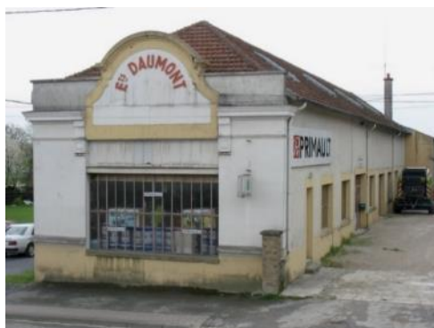
Figure 104 : Magasin et atelier d'entretien agricole des établissements Daumont à Vouziers de 1922 (Auteur Bruno Decrock)
