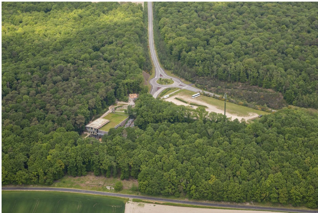
Figure 75 : vue aérienne du Parc Argonne Découverte, Source : Photo aérienne © Valeur Image Production, CD08, 2019
