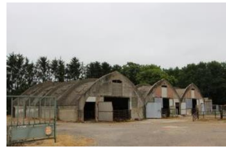
Figure 117 : Etable en béton de Albert Caquot, Vouziers, Source AUDRR
