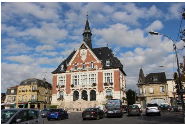
Figure 80 : Mairie de Vouziers à l'architecture monumentale (Auteur AUDRR)
