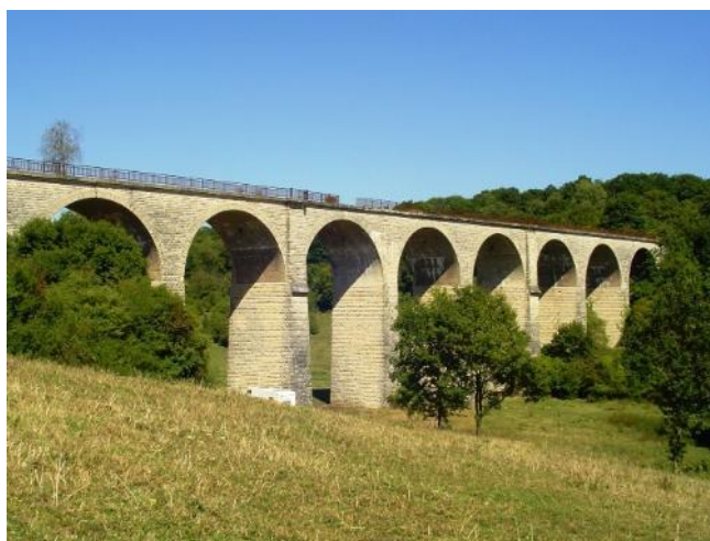
Figure 88 : Viaduc d'Ariéthel à Exermont (Banque d'image de l'Argonne ardennaise)
