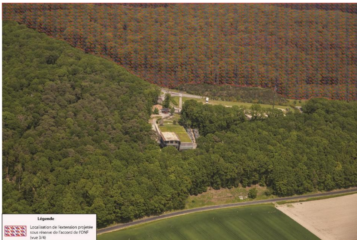
Figure 78 : vue aérienne du projet d'extension, Source : Photo aérienne © Valeur Image Production, CD08, 2019
