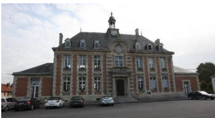
Figure 76 : Mairie à l'architecture monumentale, richement décorée de Monthois (Auteur Francis Neuvens)
