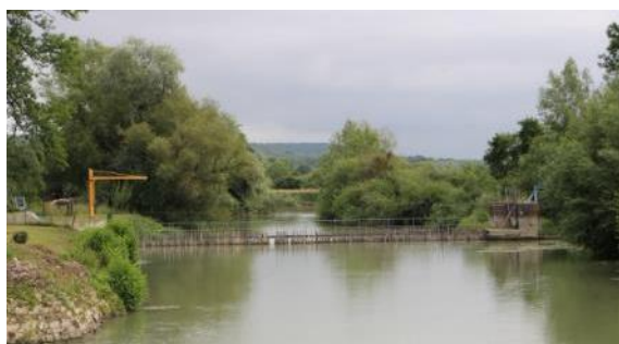
Figure 127 : Barrage sur l'Aisne à hauteur de l'écluse de Vouziers, Source AUDRR
