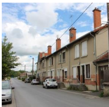
Figure 105 : Maisons ouvrières en bande à Vouziers (Source AUDRR)
