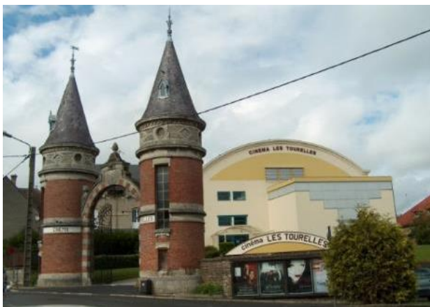
Figure 96 : Centre culturel Les Tourelles, Vouziers (Banque d'images 2C2A)
