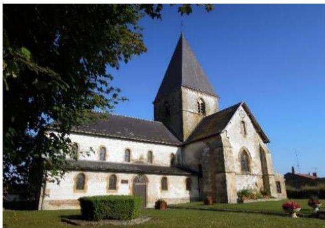
Figure 75 : Eglise Saint-Pierre et Saint-Paul de Machault à l'architecture recherchée (Auteur Claudine Lebovic)
