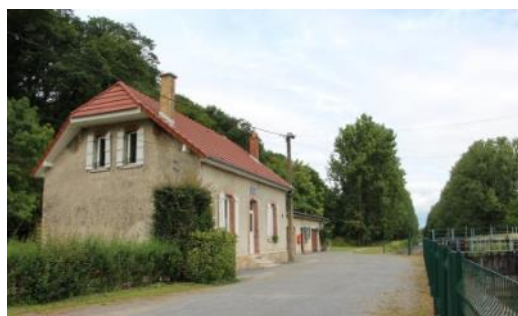
Figure 128 : Maison éclusière du canal à Vouziers, Source AUDRR
