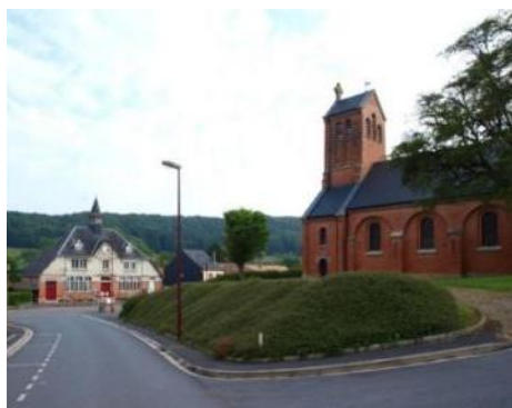
Figure 123 : Mairie et église en brique rouge de Ballay, Source AUDRR
