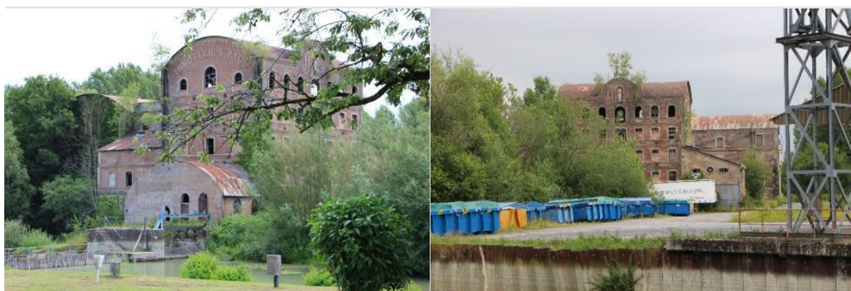
Figure 72 : Minoterie Saint-Paul, proche du port de Vouziers, Source : AUDRR 2020
